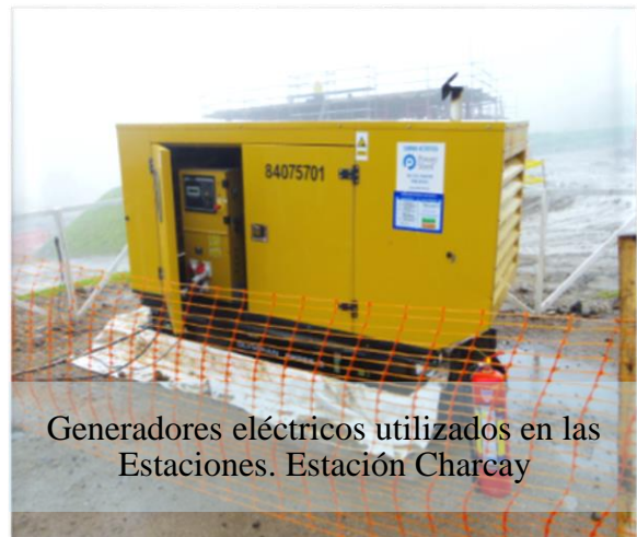
Disposición del Kit de emergencia en la Estación Charcay. Encargado de SSO de la contratista Odebrecht
