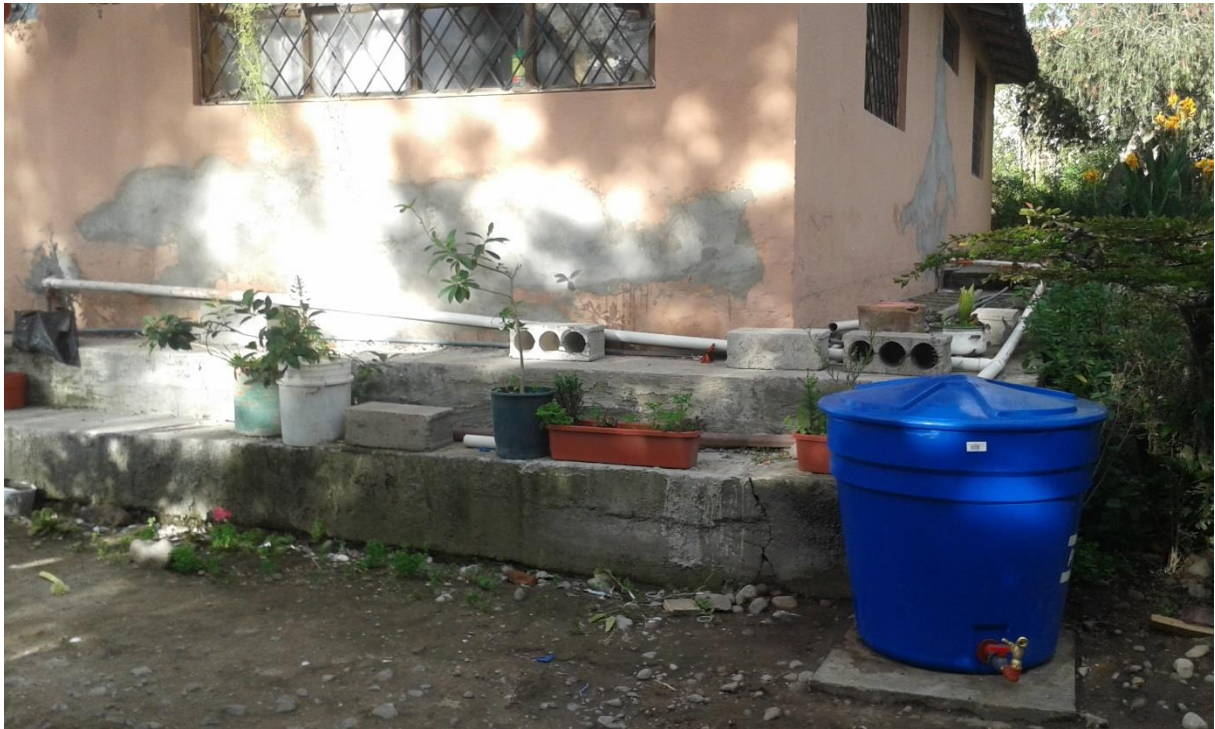
Anexo C. Fotografía del sistema de recolección de las aguas residuales domésticas grises.
