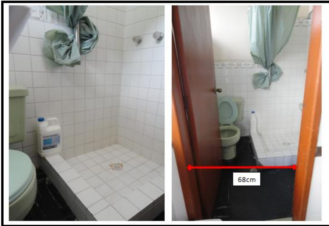
Foto 12. Baño tipo A del Servicio de Hospitalización Realizado por: María Victoria Játiva Almeida Fuente: Servicio de Hospitalización en estudio
