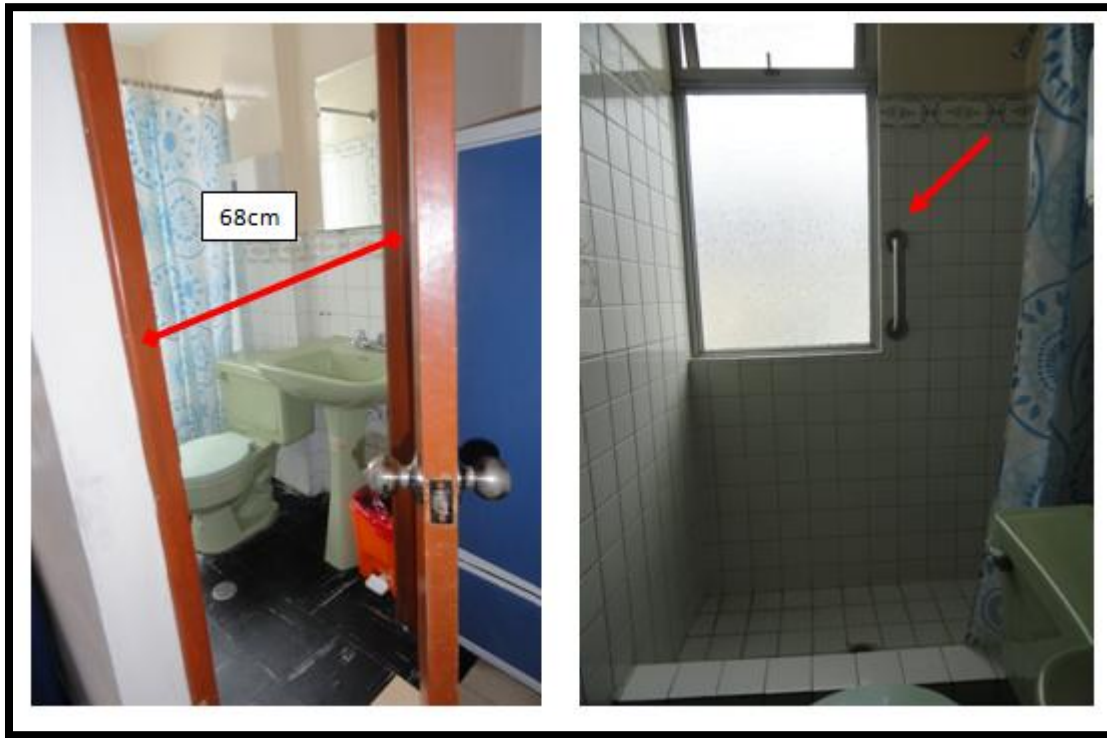
Foto 14. Baño tipo C del Servicio de Hospitalización Realizado por: María Victoria Játiva Almeida Fuente: Servicio de Hospitalización en estudio
