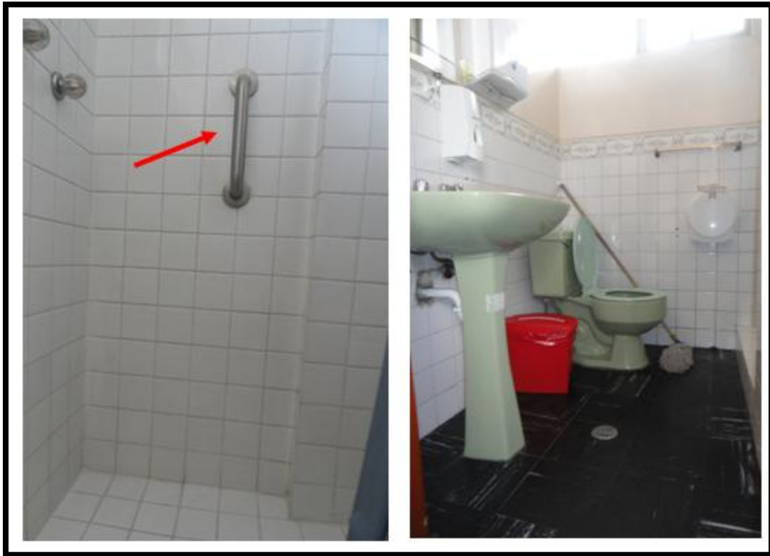
Foto 13. Baño tipo B del Servicio de Hospitalización Realizado por: María Victoria Játiva Almeida Fuente: Servicio de Hospitalización en estudio
