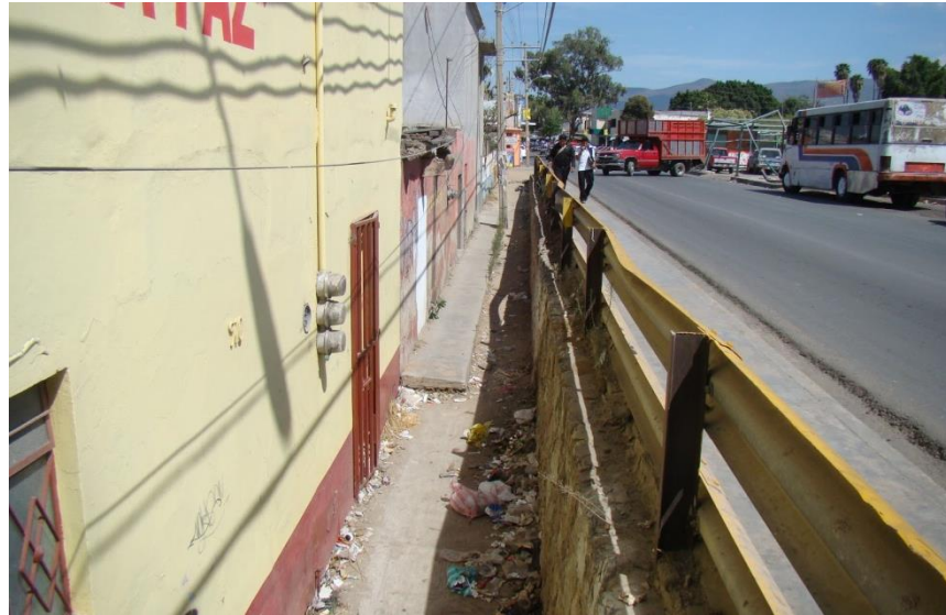
Imagen 64. Espacio residual entre edificaciones y calzada
