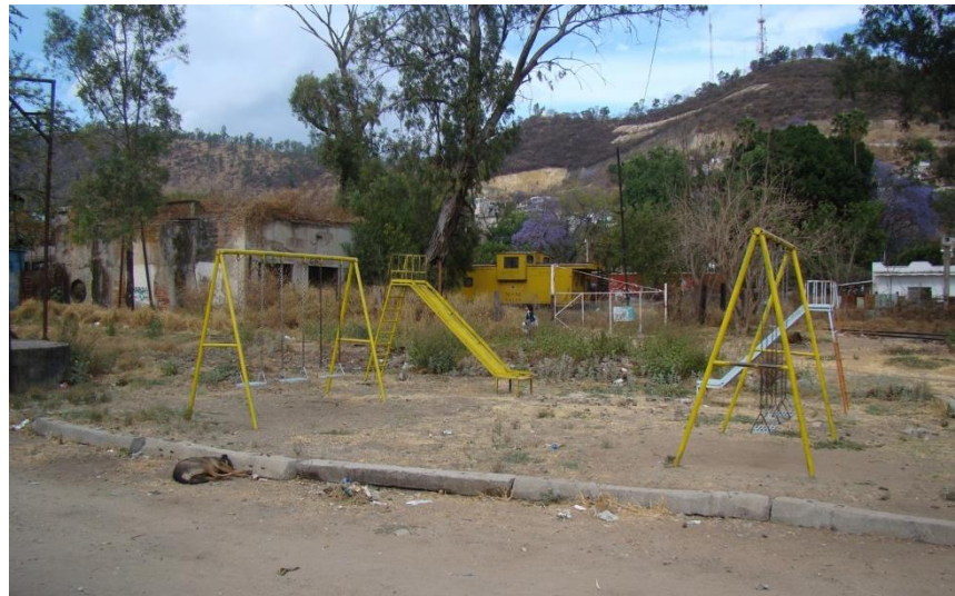
Imagen 65. Parque infantil en mal estado. Espacio residual
