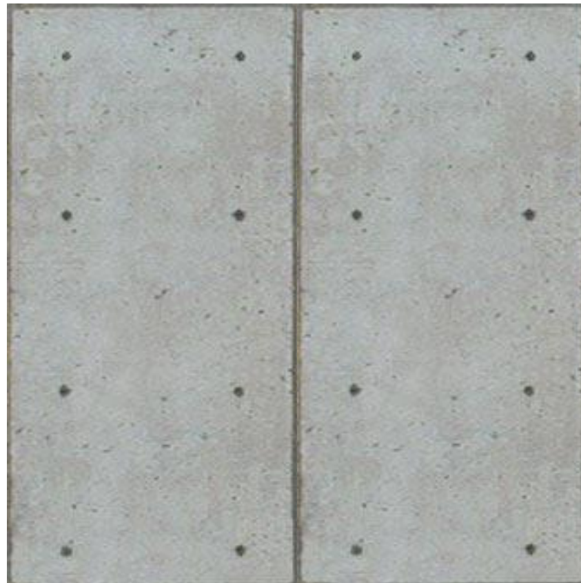
Imagen 166. Fachada de hormigón Fuente: Google Sketchup
