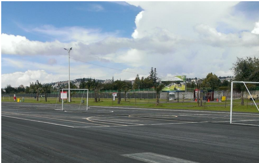
Imagen 101 - Canchas Parque Bicentenario
