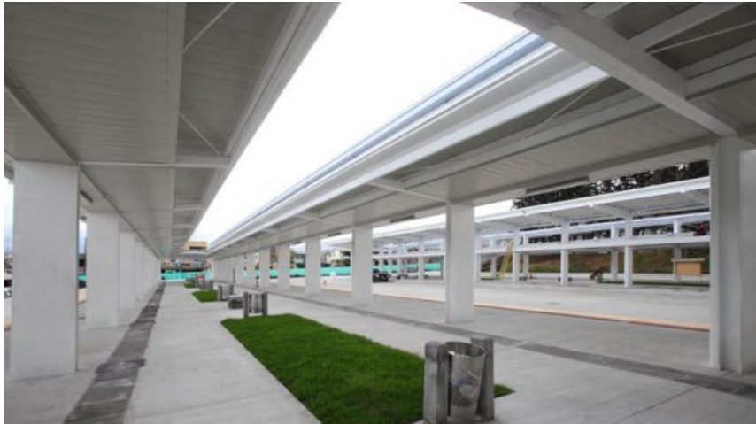
Imagen 107 - Estación Metro de Quito "El Labrador"
