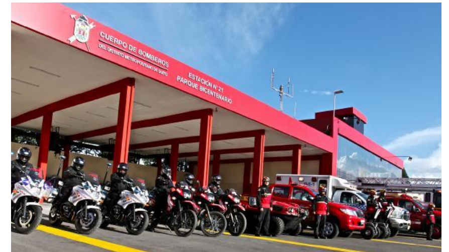
Imagen 105 - Estación de Bomberos N 21, Parque Bicentenario
