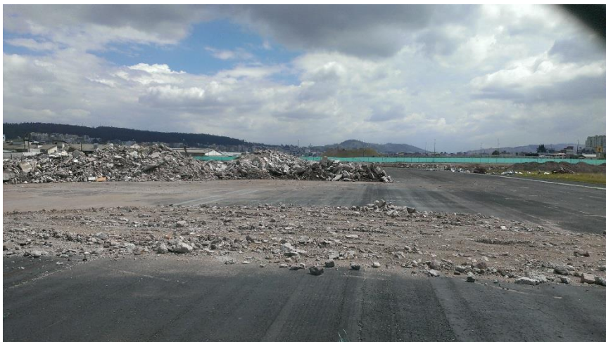
Imagen 102 - Construcción tramo sur del Parque Bicentenario
