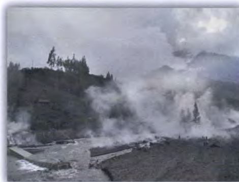
Puente destruido por los lahares en Quero, 2006 Fuente: Diario El Comercio
