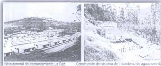
Vista general del resesentamiento La Paz
