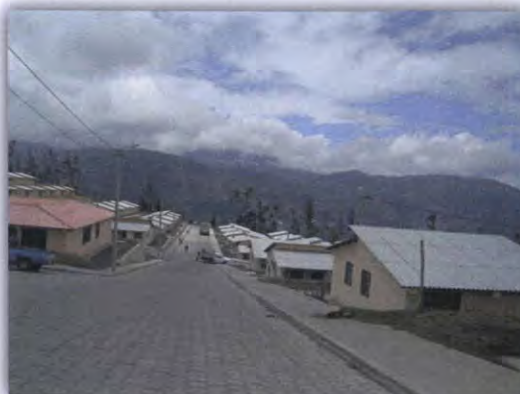
Vías internas de circulación, adoquinado, aceras y alumbrado Toma: Propia
