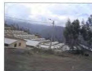
Vista general del asentamiento
