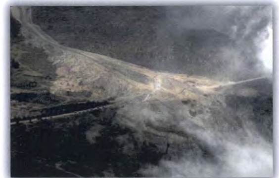
Carretera Ambato-Baños después del desastre, 2006 Fuente: Diario El Comercio
