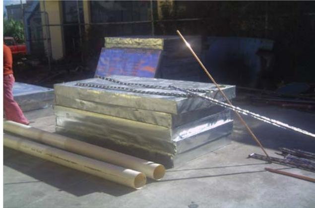
Figura 17. Forrado de las cajas con tol galvanizado
