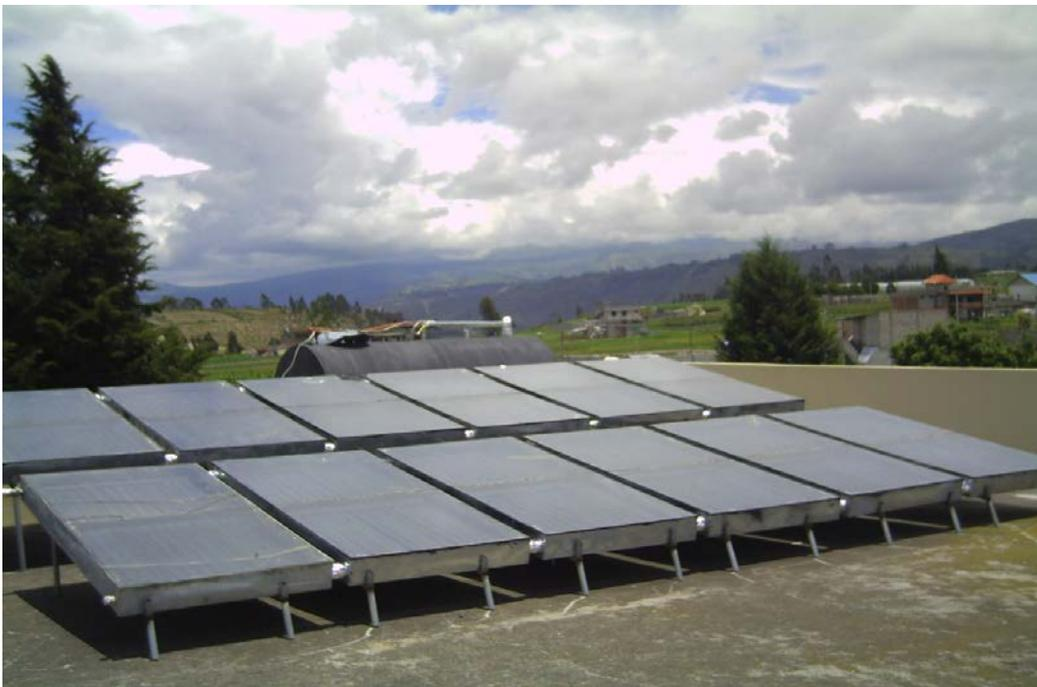
Figura 24. Instalación Terminada y funcionando del sistema de colectores
