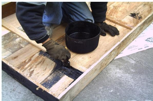
Figura 16. Aplicación de una capa de brea a las cajas
