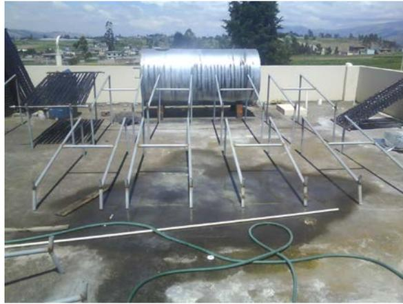
Figura 20. Construcción de estructuras de soporte para los colectores solares
