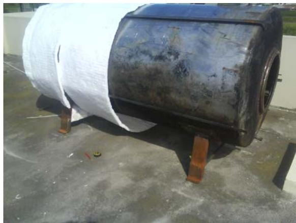
Figura 21. Reconstrucción del Tanque intercambiador de calor
