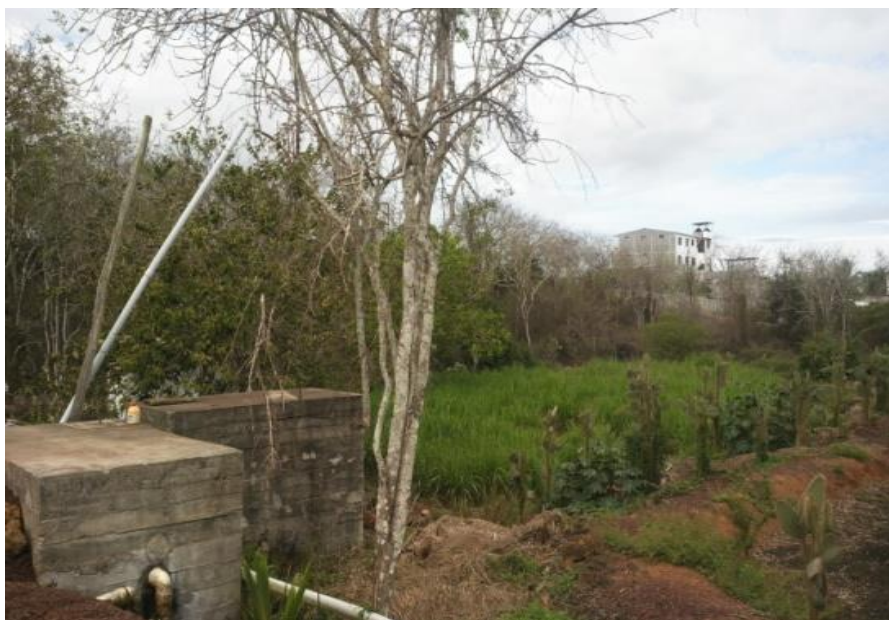
F2: Tanques de almacenamiento de Aguas residuales (grises y negras).
