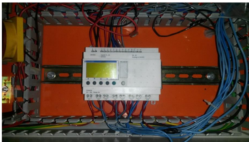
Figura 29. Montaje del controlador Zelio
