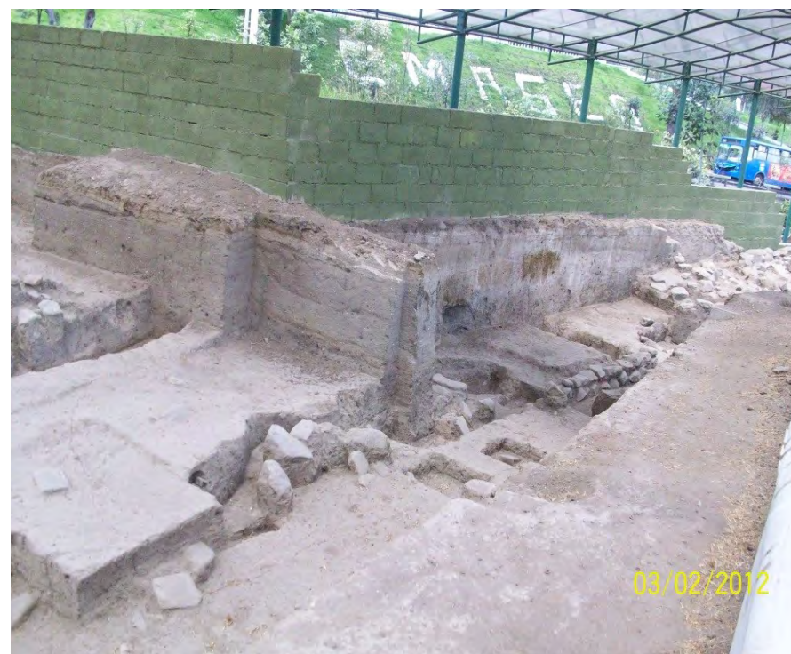
Fotografía 46: Mampostería de piedra
