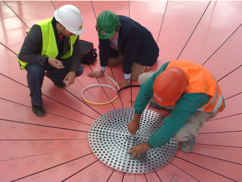
Imagen 130. Sistema de Drenaje y colección de agua
