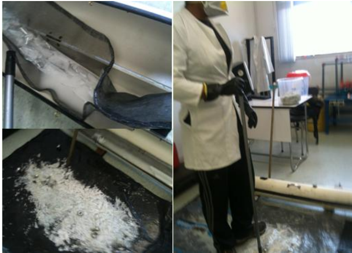
Figura 20. Retiro de vidrios rotos
