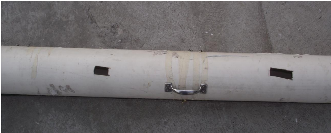
Figura 13. Orificios para vigas
