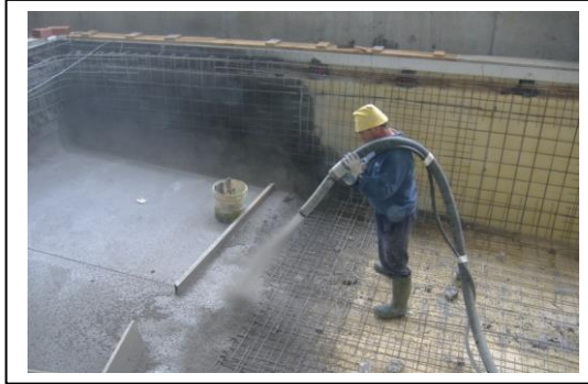
Imagen #54 Gunitado de Hormigón
