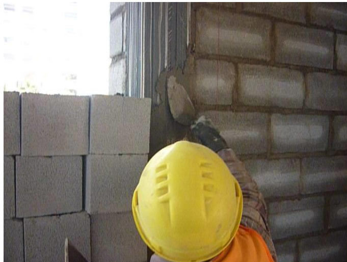
Fotografía 3. Enlucido de Paredes
