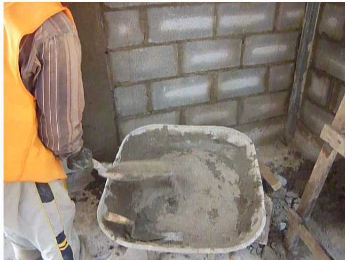
Foto 1. Preparación del Mortero
