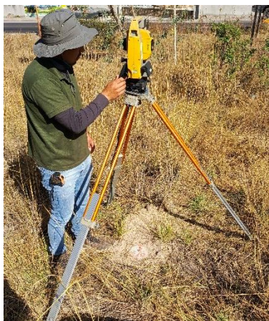
Figura 13 Colocación de la estación total
