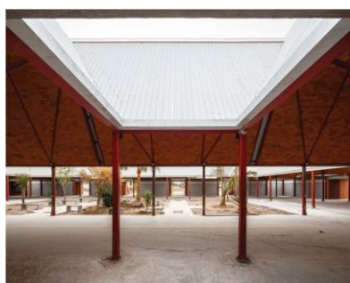
CERRAMIENTO PORTANTE CUBIERTA APORTICADO
