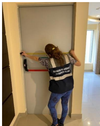
Medición de la puerta de emergencia.
