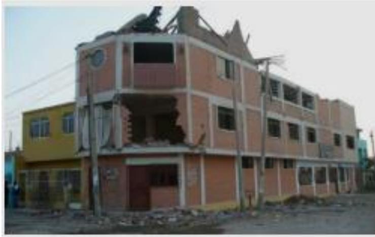
Figura 8. Ampliaciones de construcción con falta de supervisión técnica.
