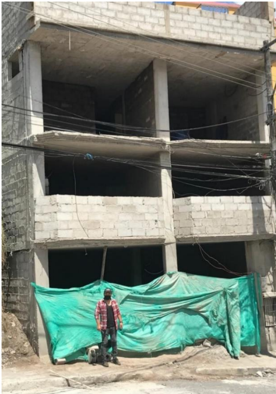
Vivienda en construcción
