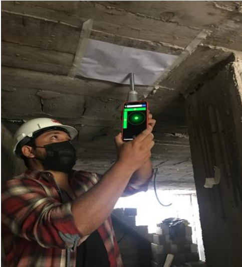
Figura 3.5 Ensayo de una viga de hormigón con el esclerómetro
