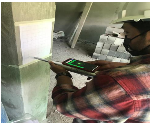
Figura 3.4 Ensayo de una columna de hormigón
