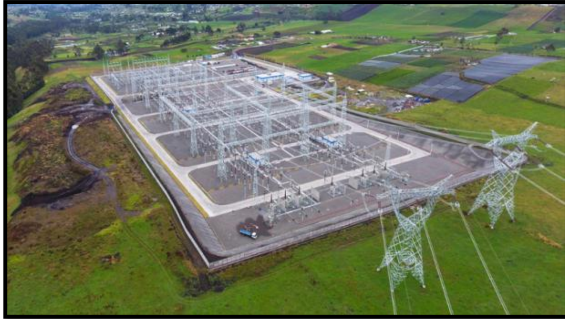
Ilustración 4. Torre de retención o remate
