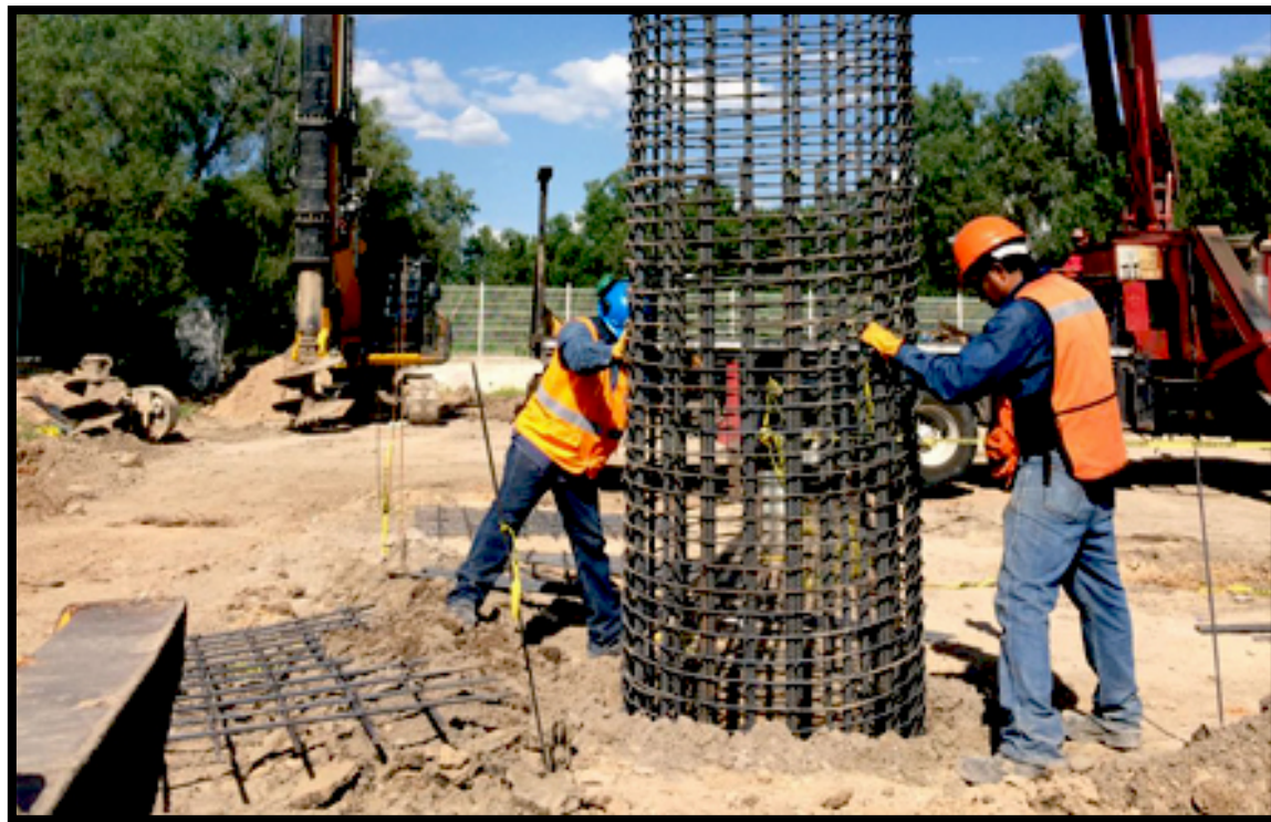
Ilustración 10. Colocación de armadura de pilas
