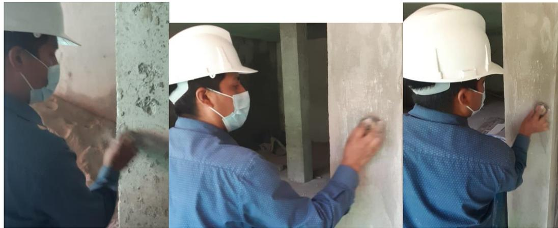
Figura 3.1. Preparación de la superficie.
