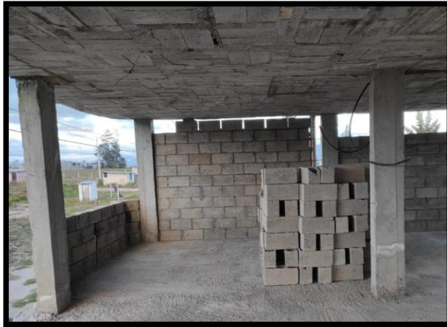
Figura 3.18. Sistema estructural “pórticos resistentes a momento”.
