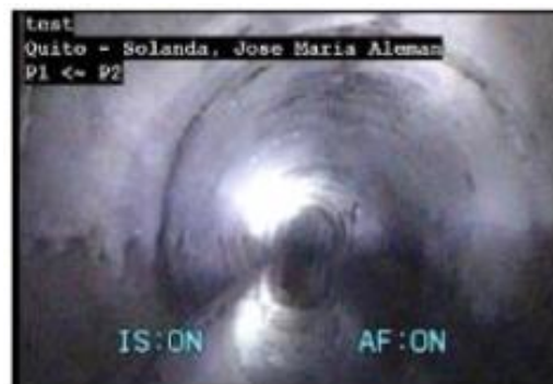
Foto: 1_4A 0m, Fractura longitudinal, en 09 en punto, within 200mm of joint: NO, Arrancar / Se recomienda la reparación total del tramo.
