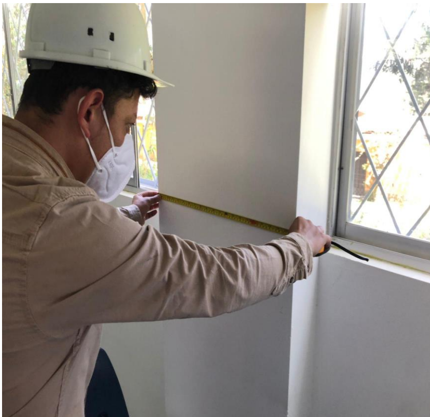
Figura 83. Medición de columnas interiores.
