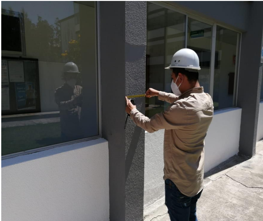
Figura 84. Medición de columnas.
