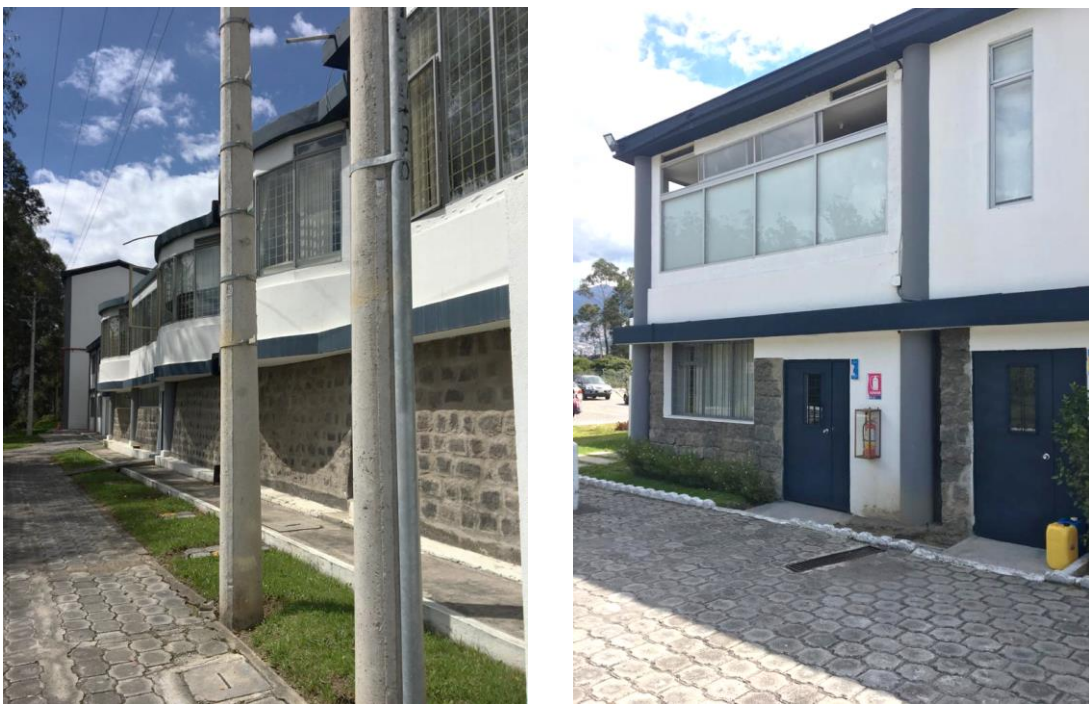
Ilustración 5 Fotografías de la planta baja del bloque.
