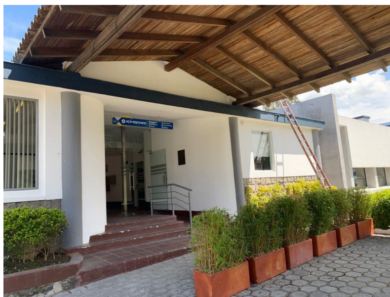
Ilustración 24 Entrada del Bloque Administrativo
