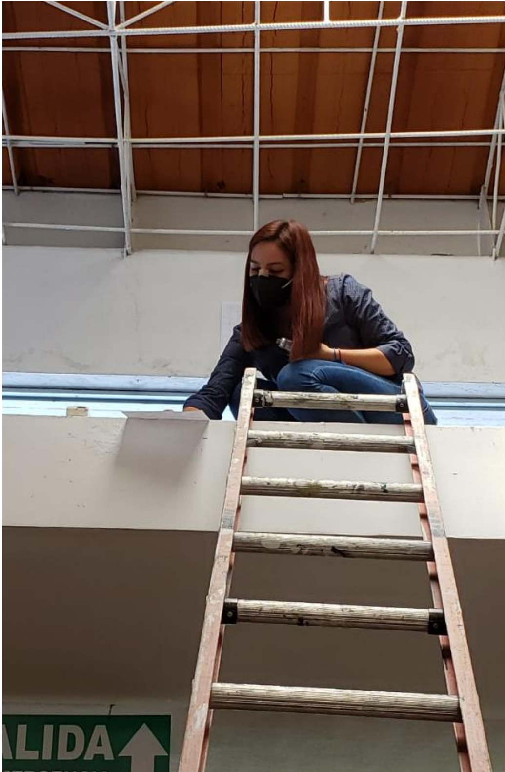
Anexo 5 Ensayo de esclerómetro en altura
