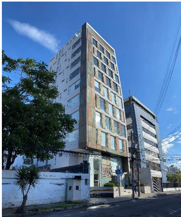
Figura 33: Fachada edificio Felipe Segovia Olmo.
