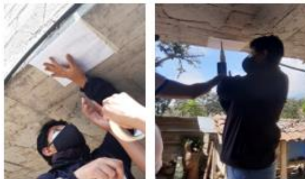
Ilustración 66: Esclerómetro en Viga lateral derecha.
