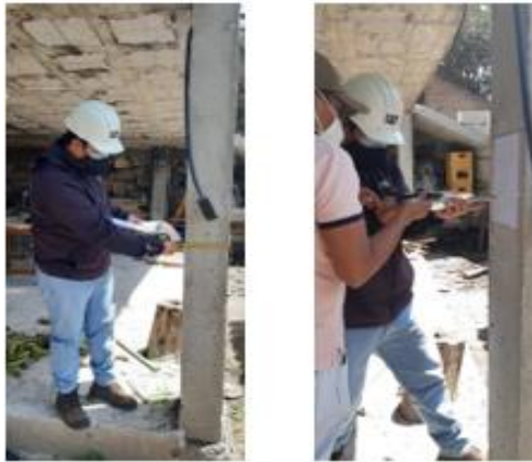
Ilustración 65: Esclerómetro en columna esquinera.
