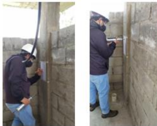
Ilustración 69: Esclerómetro en Columna medianera.
