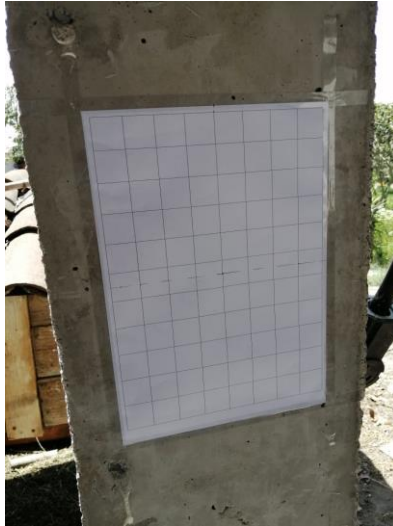
Ilustración 62: Superficie lisa, colocación de la cuadrícula.
