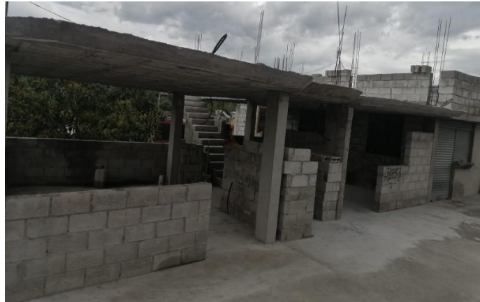
Ilustración 58: Vista frontal de la edificación.
