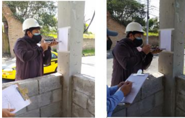
Ilustración 70: Esclerómetro en columna esquinera.
