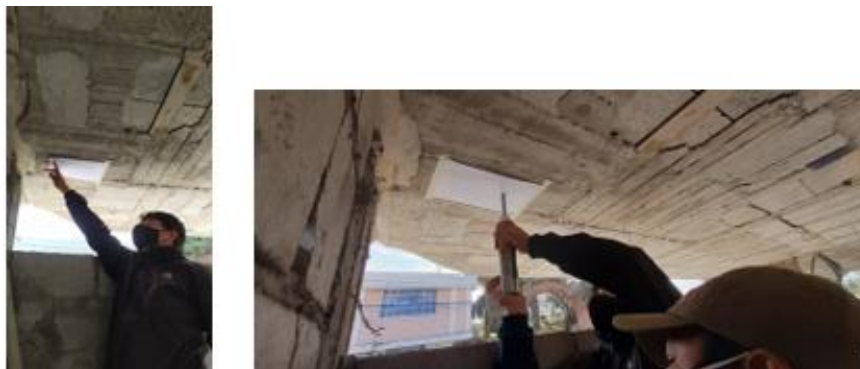
Ilustración 72: Esclerómetro en Viga frontal.
