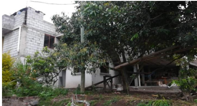
Ilustración 59: Vista Posterior de la edificación.
