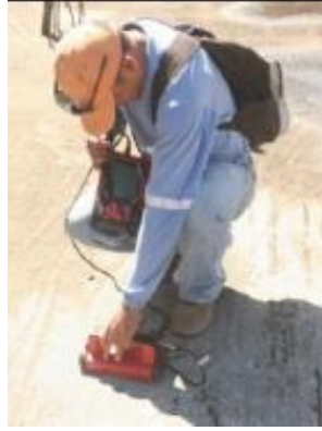
Ilustración 35: Escaneo en la losa con el pachómetro.
