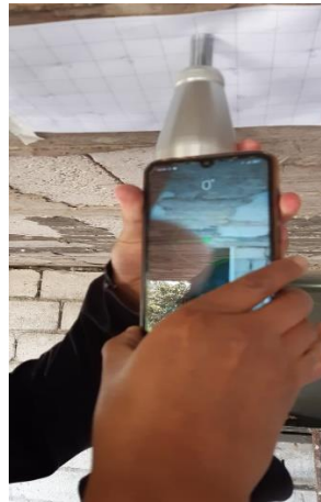
Ilustración 71 : Esclerómetro en viga central.
