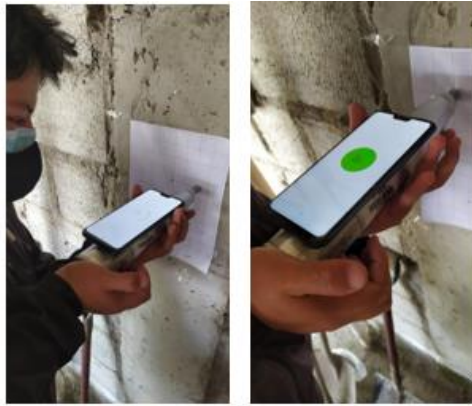
Ilustración 64: Esclerómetro en columna medianera.
