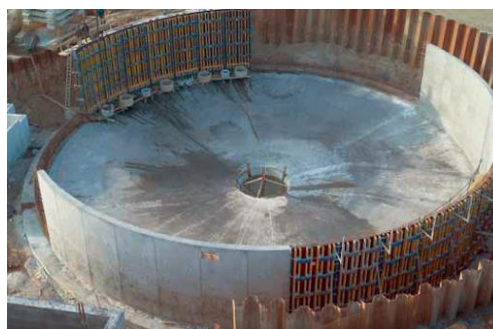
Gráfico N° 6: Encofrado y desencofrado de muros Fuente: (Imagen ilustrativa de internet)
