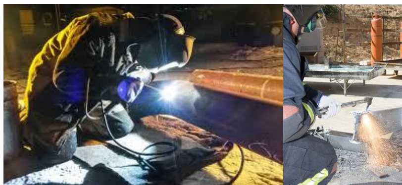
Gráfico N° 9: Trabajos de soldadura eléctrica y corte oxiacetilénico Fuente: (Imagen ilustrativa de internet)
