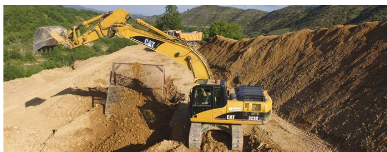
Gráfico N° 2: Maquinaria en excavación. Fuente: (Imagen ilustrativa de internet)
