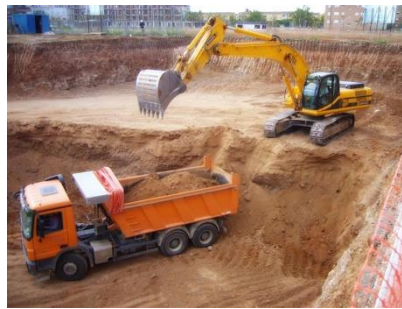
Gráfico N° 3: Volquetas en acarreo de tierras. Fuente: (Imagen ilustrativa de internet)
