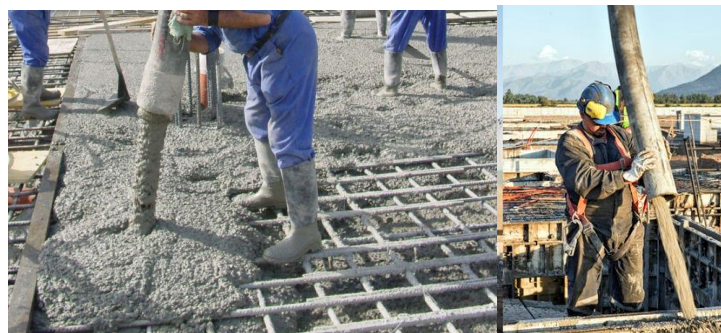
Gráfico N° 7: Hormigonado de solera y muros Fuente: (Imagen ilustrativa de internet)
