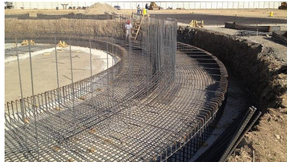
Gráfico N° 5: Armado estructural de hierro. Fuente: (Imagen ilustrativa de internet)
