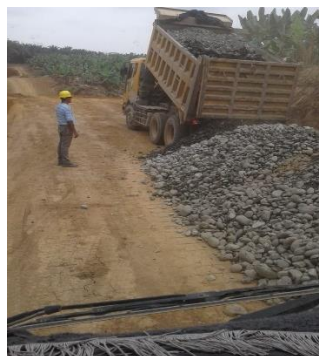
Gráfico N° 4: Mejoramiento de suelo con material pétreo. Fuente: (Imagen ilustrativa de internet)
