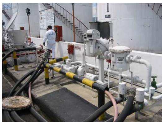
Imagen 7-67-8 Sistema de filtrado de AVGAS previo a su almacenamiento (Ecuafuel, Aeropuerto Mariscal Sucre)
