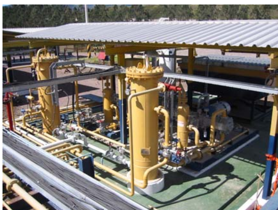
Imagen 1-52 Sistema de licuefacción. Terminal GLP Oyambaro
