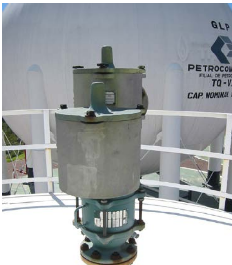
Imagen 10-32 Chimenea/válvula de alivio en tanque SLOP. Terminal GLP Oyambaro
