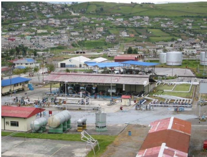
Imagen 10-14 10-13 . Estación de bombeo Beaterio. A la derecha se ve el manifold que comunica la tubería de conducción con cada uno de los tanques de almacenamiento de productos limpios.
