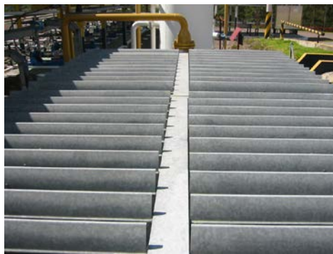
Imagen 10-36. Intercambiador de calor, sistema de licuefacción. Terminal GLP Oyambaro
