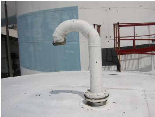
Imagen 10-7 11-9 . Cuello de ganso en tanque de techo fijo cónico. Ecuafuel.
