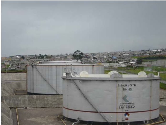
Imagen 10-8-7. Tanques de almacenamiento de distinto diseño. Techo flotante externo (adelante) y techo fijo cónico (atrás)
