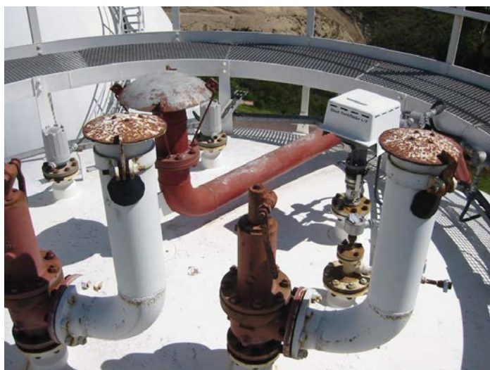
Imagen 10-3341-29. Equipos y válvulas instaladas en domo superior de una de las esferas de almacenamiento: 2 válvulas de seguridad, censores sensores de temperatura y presión, radar, sistema de enfriamiento. Terminal GLP Oyambaro.
