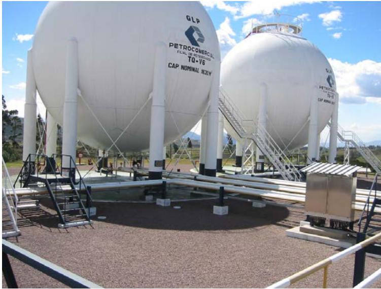
Imagen 10-34 11-30 . Líneas de transferencia de producto desde esferas hasta sistema de licuefacción y viceversa. Salen desde el fondo de las esferas. Terminal GLP Oyambaro.
