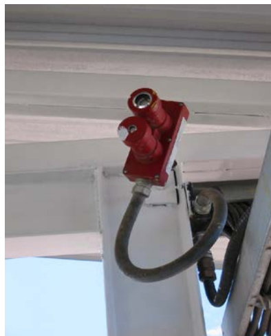
Imagen 10-38. Detector de GLP, debajo de esferas. Terminal GLP Oyambaro
