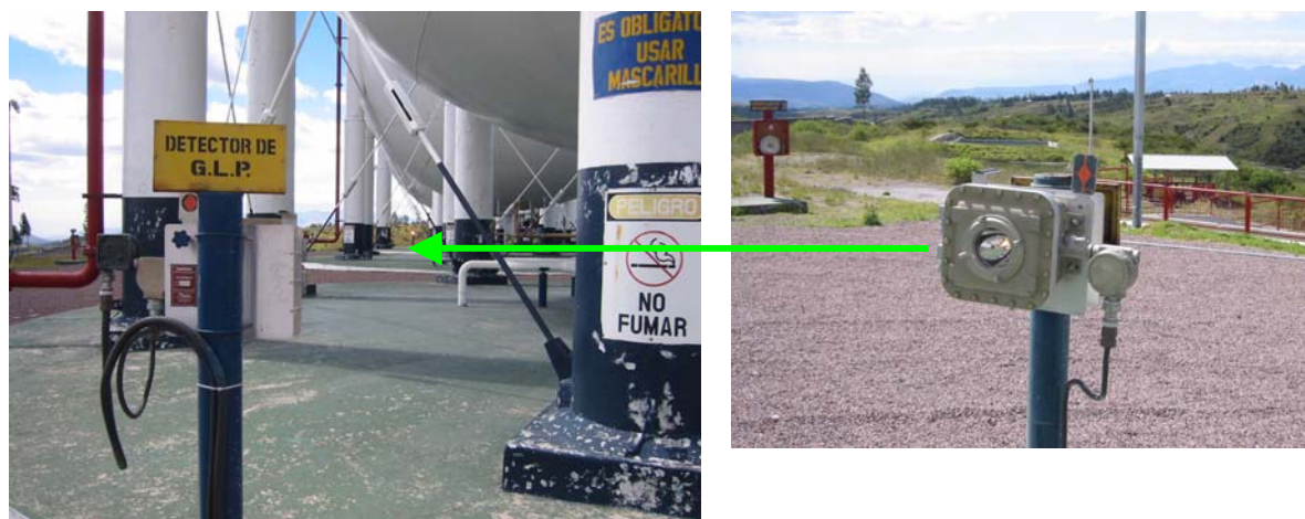
Imagen 1-56. Detector de GLP, debajo de esferas. Terminal GLP Oyambaro
