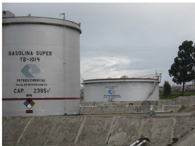
Imagen 10-10-9. Dos de los tanques de techo flotante en Terminal El Beaterio.
