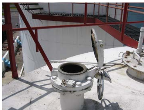
Imagen 10-8. Accesos para aforo manual, tanque techo fijo cónico. Ecuafuel
