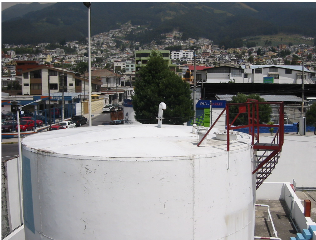
Imagen 1-17. Tanque #1, marcas de corrosión en juntas entre paredes y techo. Ecuafuel
