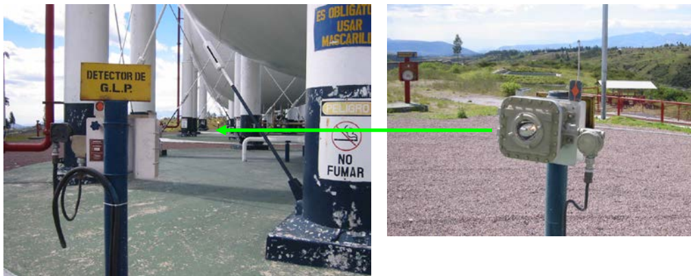
Imagen 10-38. Detector de GLP, debajo de esferas. Terminal GLP Oyambaro
