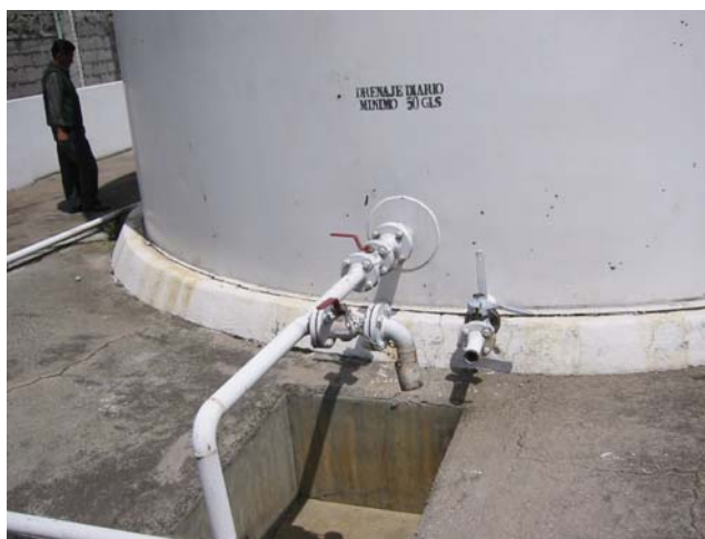
Imagen 1-12. Salida para drenaje diario, tanque #2. Ecuafuel
