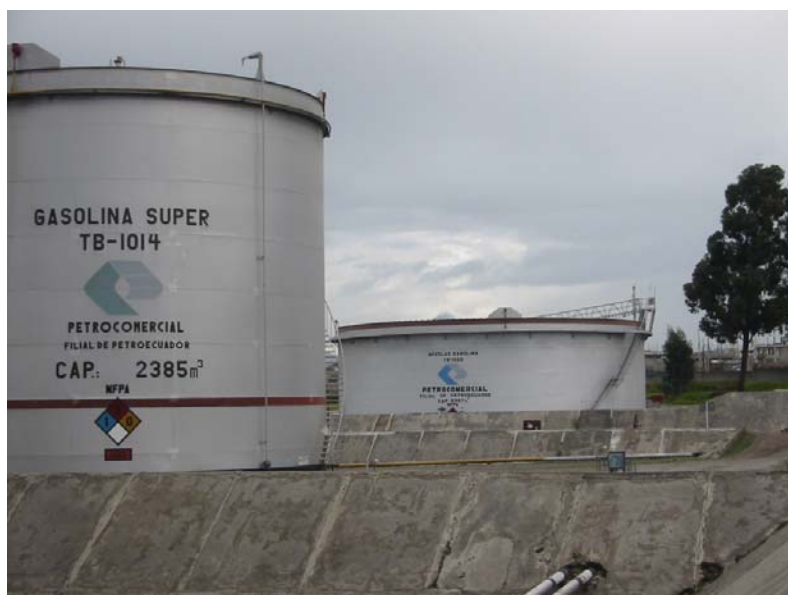
Imagen 10-17. Dos de los tanques de techo flotante en Terminal El Beaterio.
