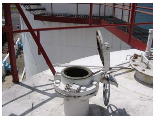
Imagen 1-11. Accesos para aforo manual, tanque techo fijo cónico. Ecuafuel
