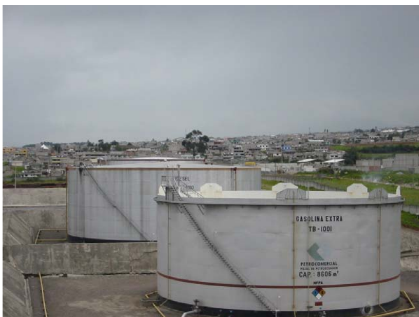
Imagen 10-13. Tanques de almacenamiento de distinto diseño. Techo flotante externo (adelante) y techo fijo cónico (atrás)
