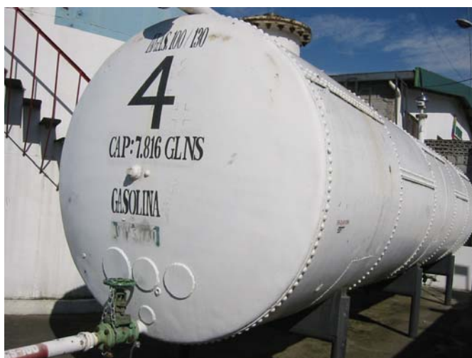
Imagen 1-7. Tanque 4. Almacenamiento AVGAS 100/130. Ecuafuel.
