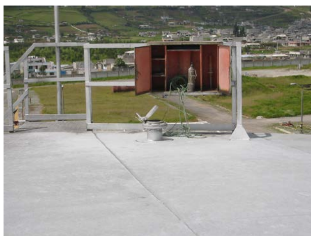
Imagen 10-1210-11. Boca de aforo abierta, sobre un tanque de techo fijo cónico.
