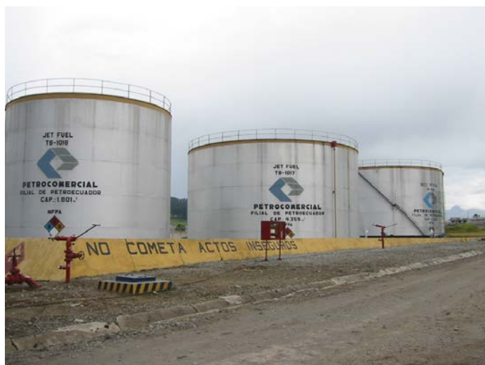
Imagen 10-11-10-10. Tres de los tanques de almacenamiento de combustibles pesados (JET A-1) en el terminal El Beaterio. Techo fijo cónico.
