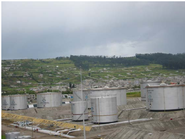
Imagen 2. Zona de almacenamiento de productos limpios. Se distinguen tanques de techo fijo cónico (izq.) y tanques de techo flotante externo (der.)
