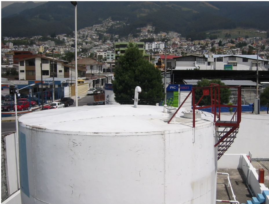
Imagen 10-1211-13. Tanque #1, marcas de corrosión en juntas entre paredes y techo. Ecuafuel
