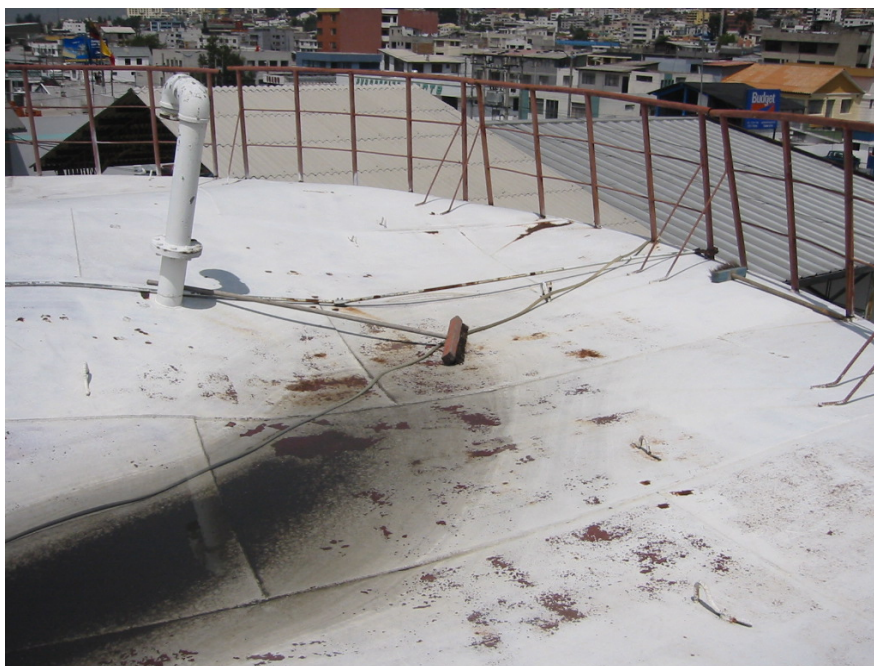
Imagen 11-6. Tanque # 6, techo hundido. Ecuafuel
