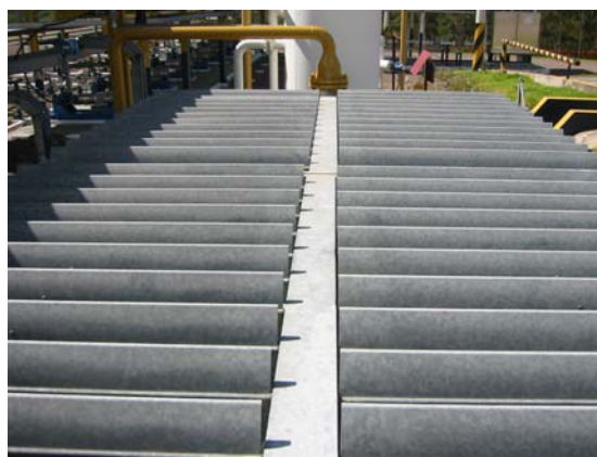
Imagen 1-53. Intercambiador de calor, sistema de licuefacción. Terminal GLP Oyambaro
