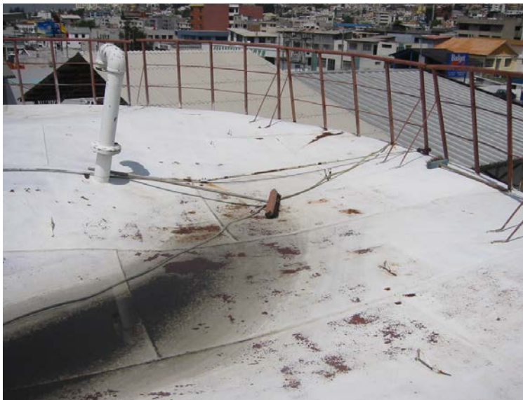
Imagen 11-6. Tanque # 6, techo hundido. Ecuafuel
