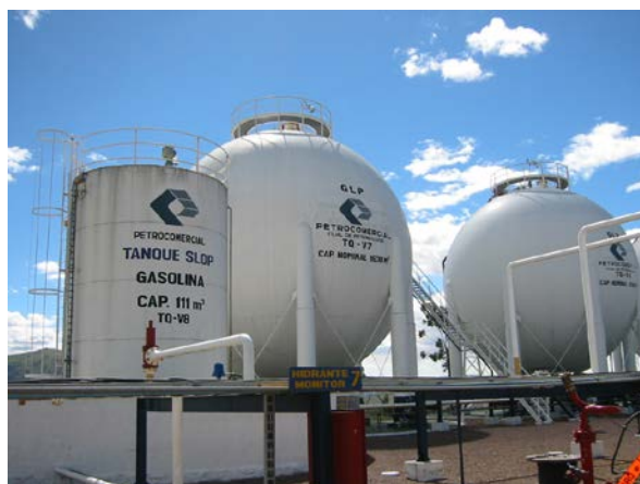
Imagen 3. Tanque SLOP (izq.), a la derecha se ven 2 de los 3 tanques esféricos de almacenamiento de GLP . Terminal GLP Oyambaro
