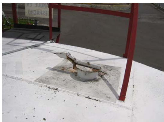
Imagen 1-11. Accesos para aforo manual, tanque techo fijo cónico. Ecuafuel
