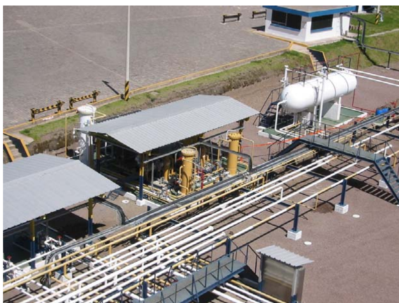
Imagen 1-45. Facilidades de transferencia de producto de un proceso a otro dentro del Terminal GLP Oyambaro.
