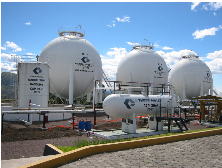
Imagen 1-44. Vista general de infraestructura de recepción de producto. Tanque Bullet, Tanque SLOP, Esferas. Terminal GLP Oyambaro.
