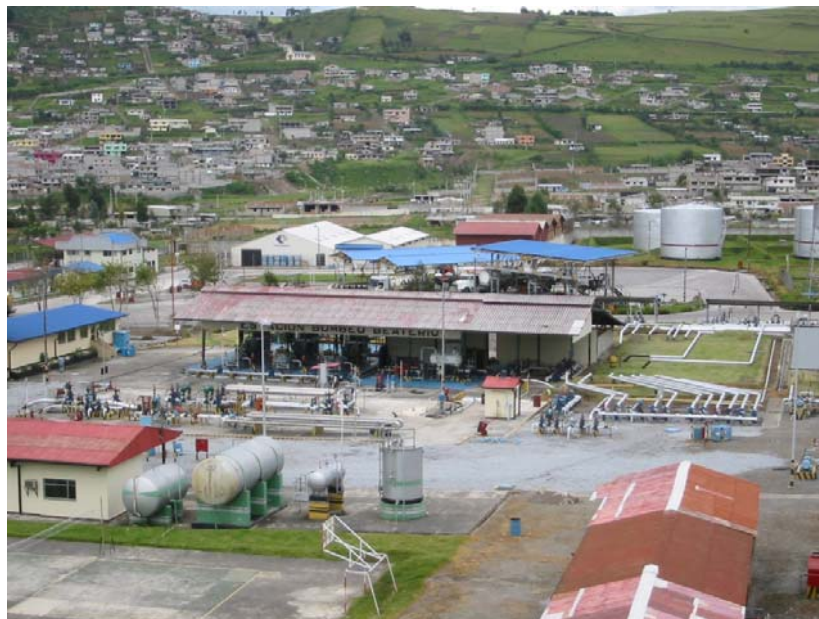
Imagen 10-25. Estación de bombeo Beaterio. A la derecha se ve el manifold que comunica la tubería de conducción con cada uno de los tanques de almacenamiento de productos limpios.
