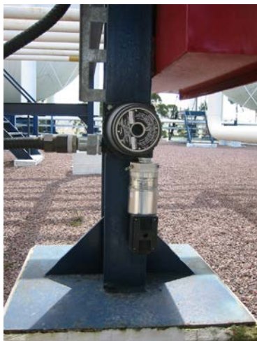
Imagen 10-38. Detector de GLP, debajo de esferas. Terminal GLP Oyambaro
