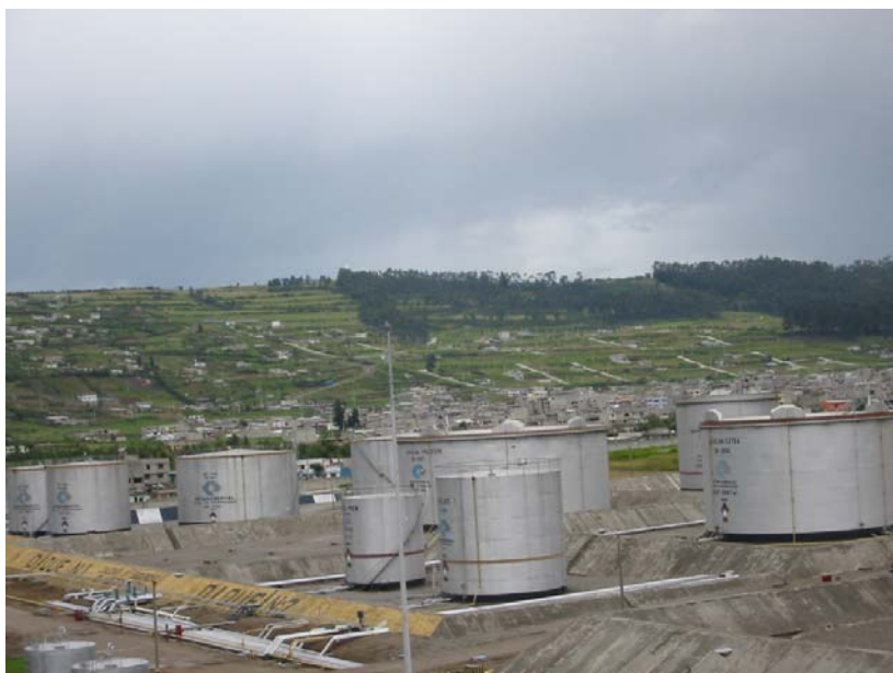
Imagen 10-11. Zona de almacenamiento de productos limpios. Se distinguen tanques de techo fijo cónico (izq.) y tanques de techo flotante externo (der.)
