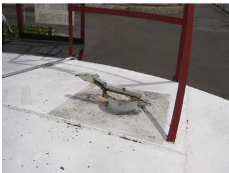
Imagen 10-8. Accesos para aforo manual, tanque techo fijo cónico. Ecuafuel
