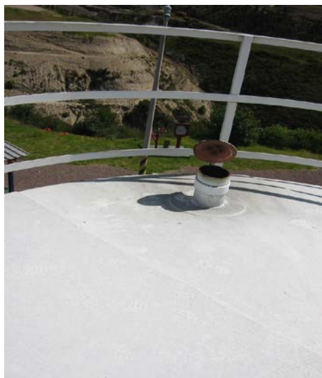
Imagen 10-31. Acceso para aforo en tanque SLOP, abierto. Terminal GLP Oyambaro.
