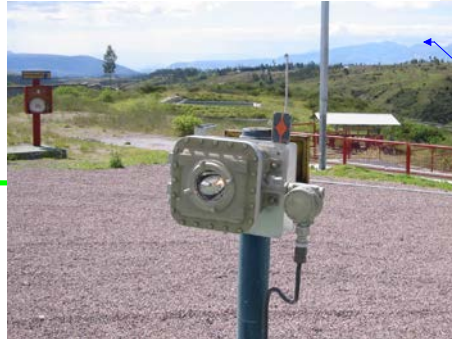
Imagen 10-39. Detectores GLP en área de bombas. Terminal GLP Oyambaro.
