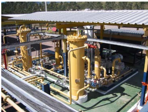
Imagen 10-35 Sistema de licuefacción. Terminal GLP Oyambaro
