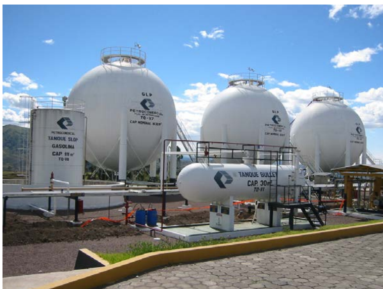
Imagen 10-29. Vista general de infraestructura de recepción de producto. Tanque Bullet, Tanque SLOP, Esferas. Terminal GLP Oyambaro.
