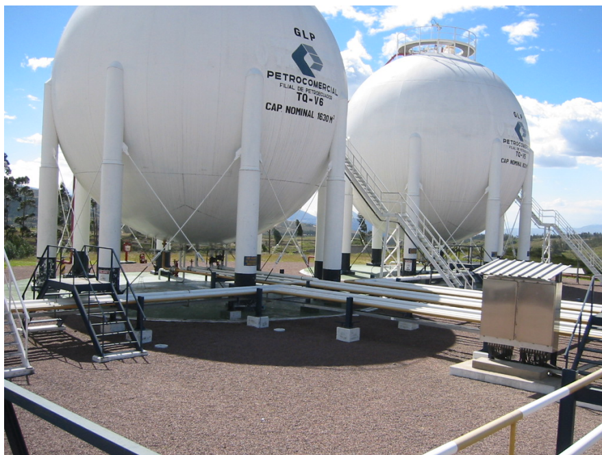
Imagen 1-50. Líneas de transferencia de producto desde esferas hasta sistema de licuefacción y viceversa. Salen desde el fondo de las esferas. Terminal GLP Oyambaro.
