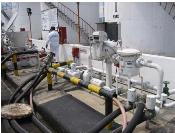
Imagen 7-11 Sistema de filtrado de AVGAS previo a su almacenamiento (Ecuafuel, Aeropuerto Mariscal Sucre)
