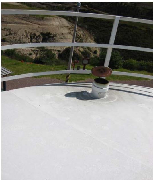
Imagen 1-46. Acceso para aforo en tanque SLOP, abierto. Terminal GLP Oyambaro.
