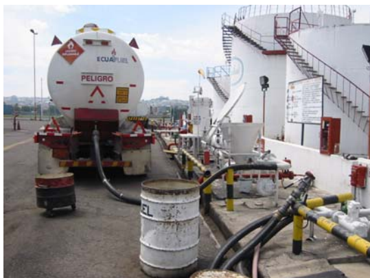
Imagen 7-8 Sistema de filtrado y pruebas cortas previo a ingreso a tanques
