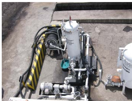
Imagen 7-57-6 Filtros para JET A-1 previo a despacho a autotanques
