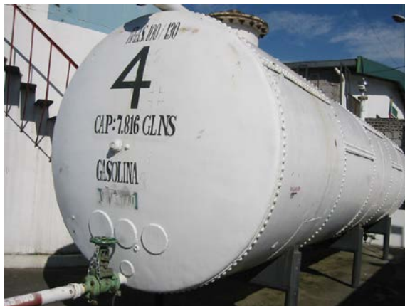
Imagen 10-511-6. Tanque 4. Almacenamiento AVGAS 100/130. Ecuafuel.
