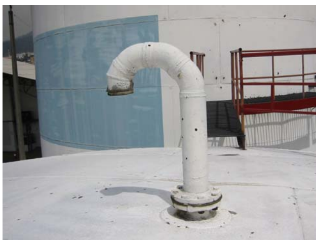
Imagen 1-10. Cuello de ganso en tanque de techo fijo cónico. Ecuafuel.
