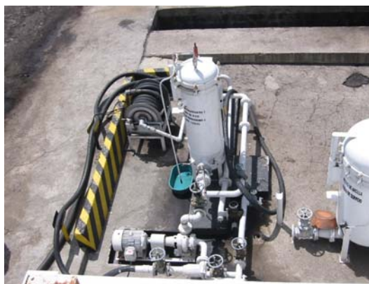
Imagen 7-9 Filtros para JET A-1 previo a despacho a autotanques
