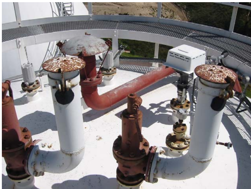
Imagen 1-48. Equipos y válvulas instaladas en domo superior de una de las esferas de almacenamiento: 2 válvulas de seguridad, sensores de temperatura y presión, radar, sistema de enfriamiento. Terminal GLP Oyambaro.
