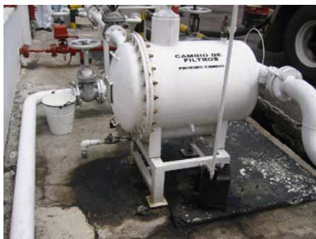
Imagen 10-10. Derrames de hidrocarburos sobre la plataforma. Ecuafuel
