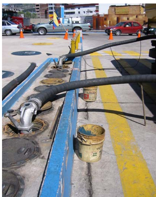
Imagen 1-28. Acople de manguera de válvula de salida de auto tanque. Petrocomercial ES (derecha)
