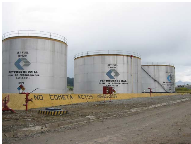
Imagen 10-19. Tres de los tanques de almacenamiento de combustibles pesados (JET A-1) en el terminal El Beaterio. Techo fijo cónico.
