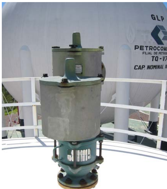
Imagen 1-47 Chimenea/válvula de alivio en tanque SLOP. Terminal GLP Oyambaro
