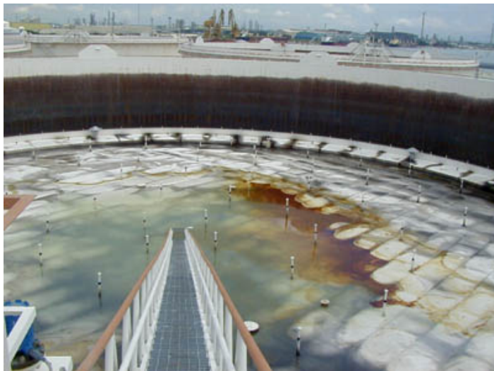
Imagen 10-9 10-8 .Techo flotante externo (no en el terminal El Beaterio). Vista de la cubierta del techo flotante, desde dentro de la circunferencia del tanque.
