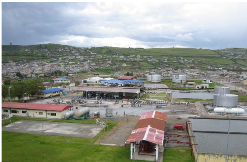
Imagen 10-340-2. Estación reductora Beaterio. En el fondo se ven los tanques SLOP
