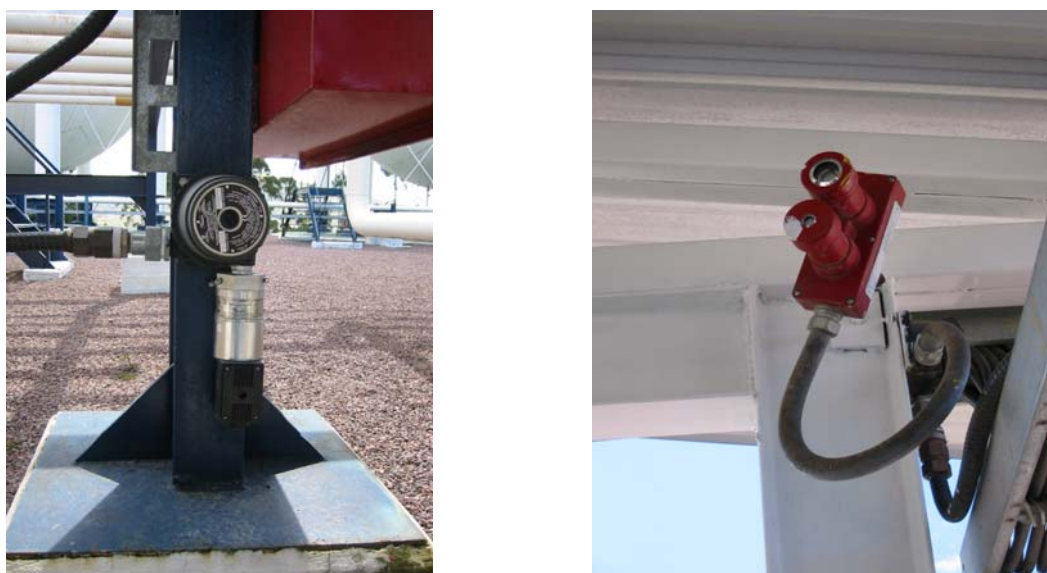
Imagen 1-56. Detector de GLP, debajo de esferas. Terminal GLP Oyambaro
