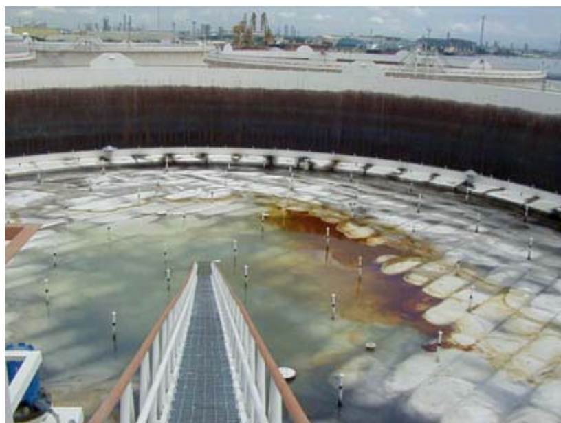
Imagen 10-15. Techo flotante externo (no en el terminal El Beaterio). Vista de la cubierta del techo flotante, desde dentro de la circunferencia del tanque.
