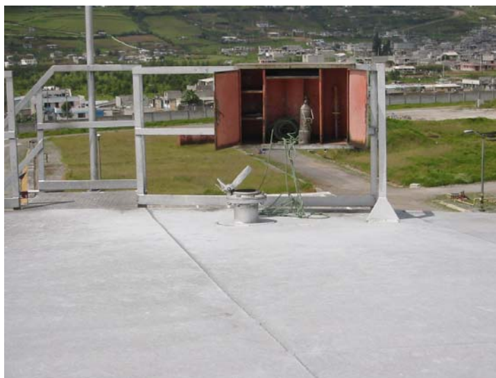
Imagen 10-21. Boca de aforo abierta, sobre un tanque de techo fijo cónico.
