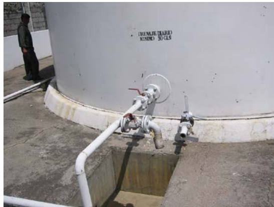
Imagen 10-911-10. Salida para drenaje diario, tanque #2. Ecuafuel
