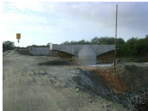
Pilas y Estribo en el Puente Norte 1
