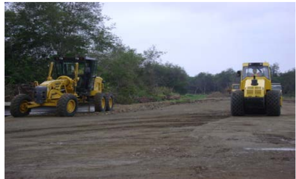
Compactación de Material en la Vía
