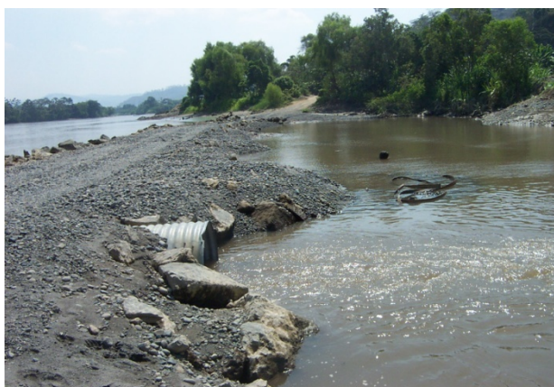
Badén Construido en el Puente Sur. (Nótese la alcantarilla para el paso del agua en marea baja)
