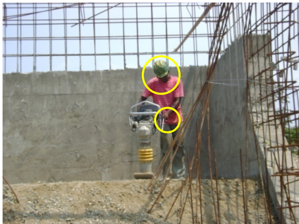
En el Estribo 2 del Puente Sur el Personal Subcontratado No Utiliza el Equipo de Protección Personal (Mascarilla de Polvos)
