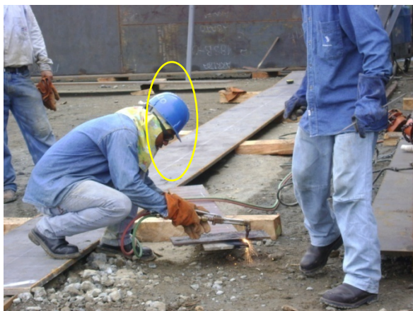
Las gafas que se utilizan no son las apropiadas para los trabajos de soldadura
