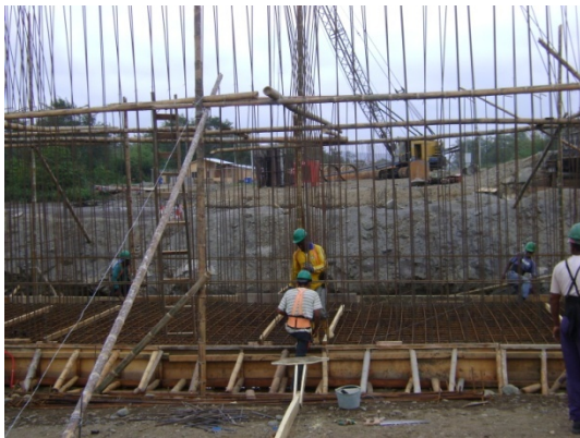
Conformación de Estribos en el Puente Sur
