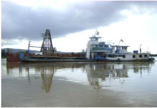
Trabajos de Pilotaje con la Ayuda de Gabarra
