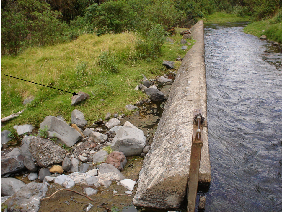
Fotografía No. 1 Canal de captación y vertedero de excesos para el río Pita.
