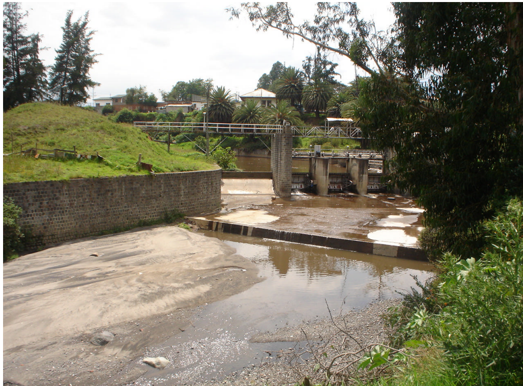
Fotografía No. 25 Cauce del río San Pedro con las Compuertas cerradas de la represa.
