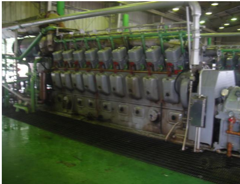
Maquina de 18 cilindros Estación Papallacta
