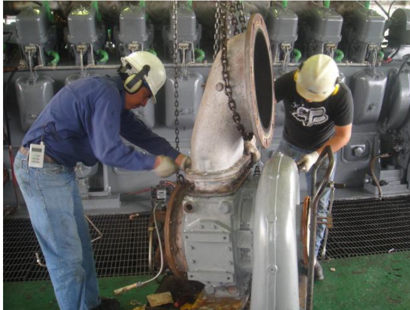
Cambio de turbina Estación Papallacta
