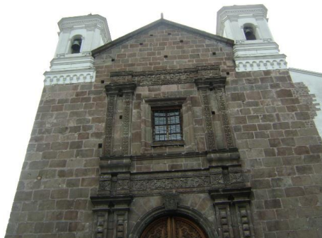
Fallada de la Iglesia del Carmen Bajo
