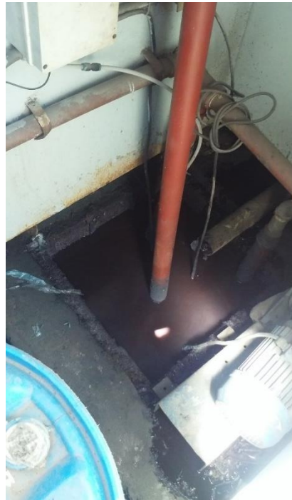
Figura 7. Punto de muestreo de la cisterna - Bomba de alimentación al reactor biológico
