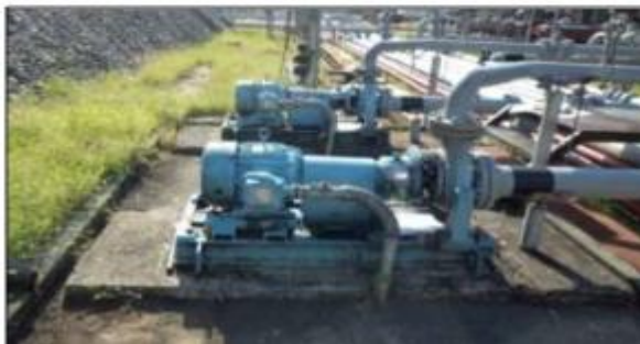
Figura 8. Bomba Booster
