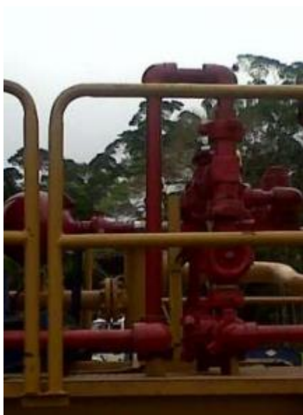
Figura 11 Manifold de inyección y producción
