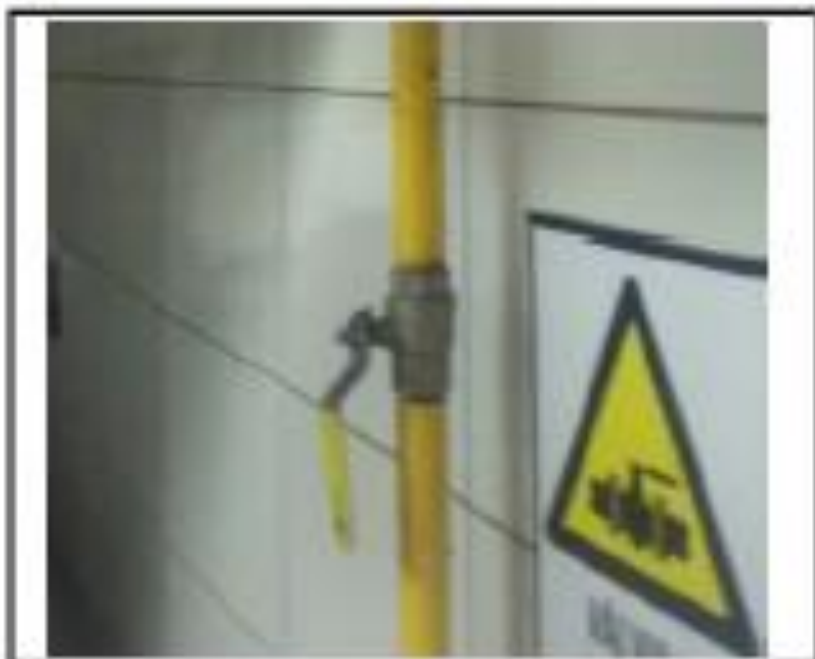
Aislamiento de tramo de prueba
