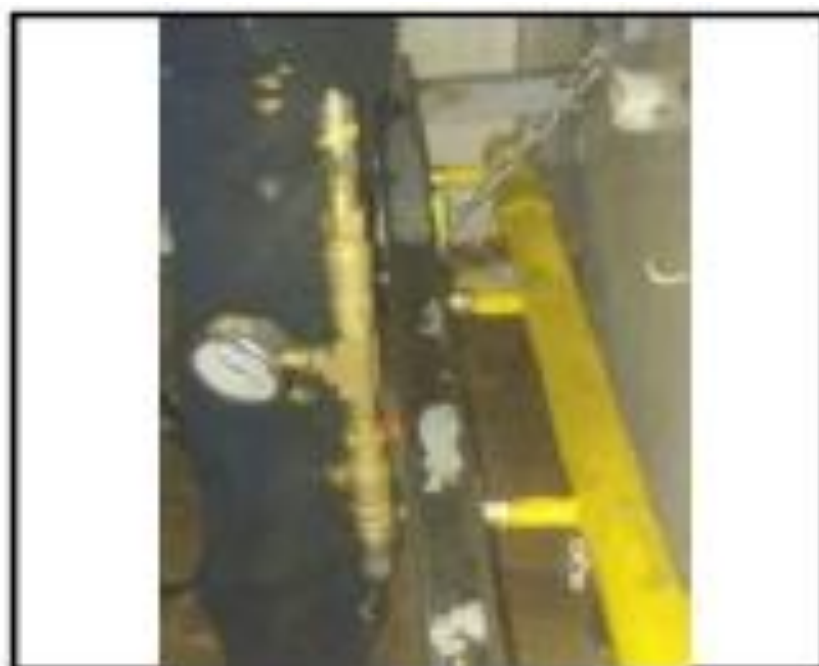
Desmontaje de equipos
