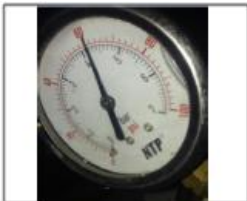
Presurización de tubería
