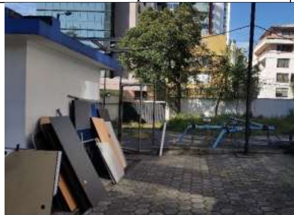
Fotografía 5: Entrada a las instalaciones del pozo
