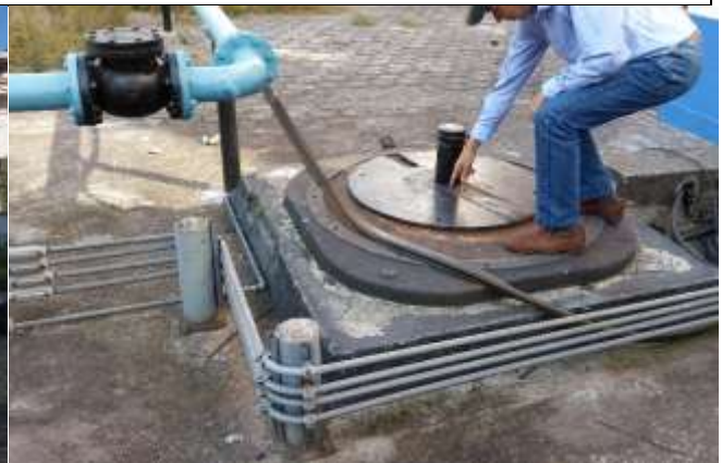
Fotografía 6: Instalaciones del pozo
