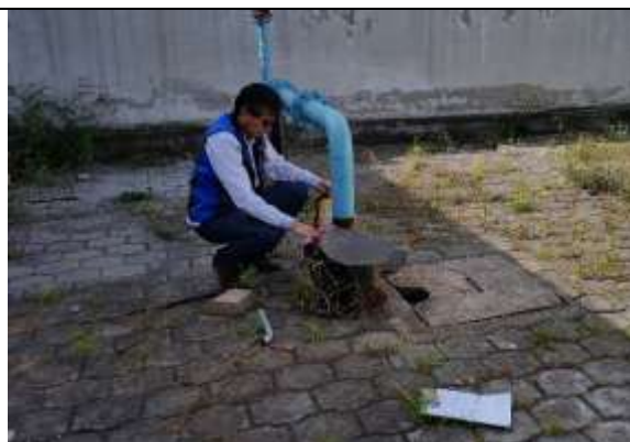
Fotografía 2: Toma nivel piezométrico
