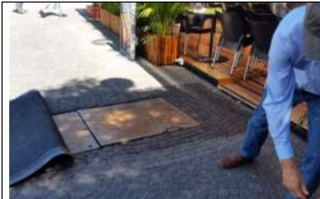
Fotografía 1: Ingreso a cámara subterránea pozo 12A
