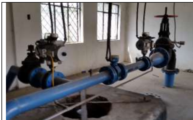
Fotografía 1: Instalaciones pozo antiguo
