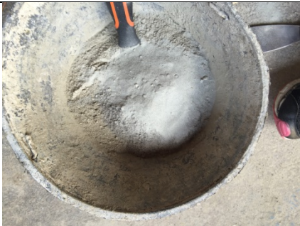
Mezcla de los materiales en seco
