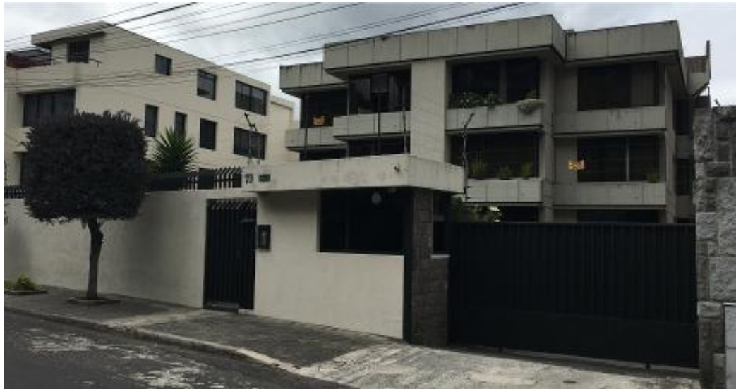
Figura 0.11: Casetas no interrumpen el paso en la acera.
