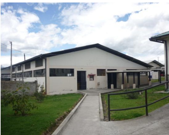
Cuarto de Maquinas
