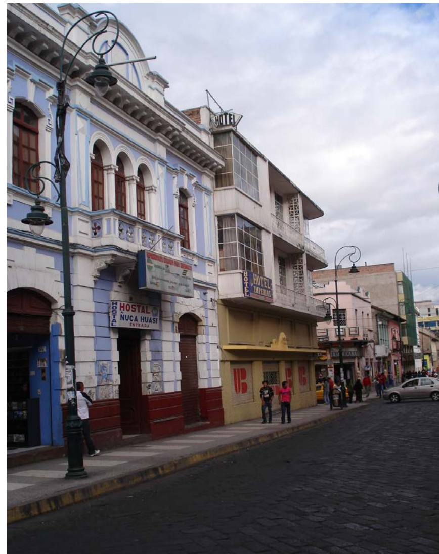
FUENTE: Archivo personal Calle 10 de Agosto y Magdalena Dávalos. RIOBAMBA (tomado sábado 27 de marzo de 2010) ARQUITECTURA DEL SIGLO XVIII COMBINACIÓN DE MODERNISMO DEL SIGLO XX. CONSERVACIÓN DE LA PIEDRA EN ADOQUINADO DE CALLES.
