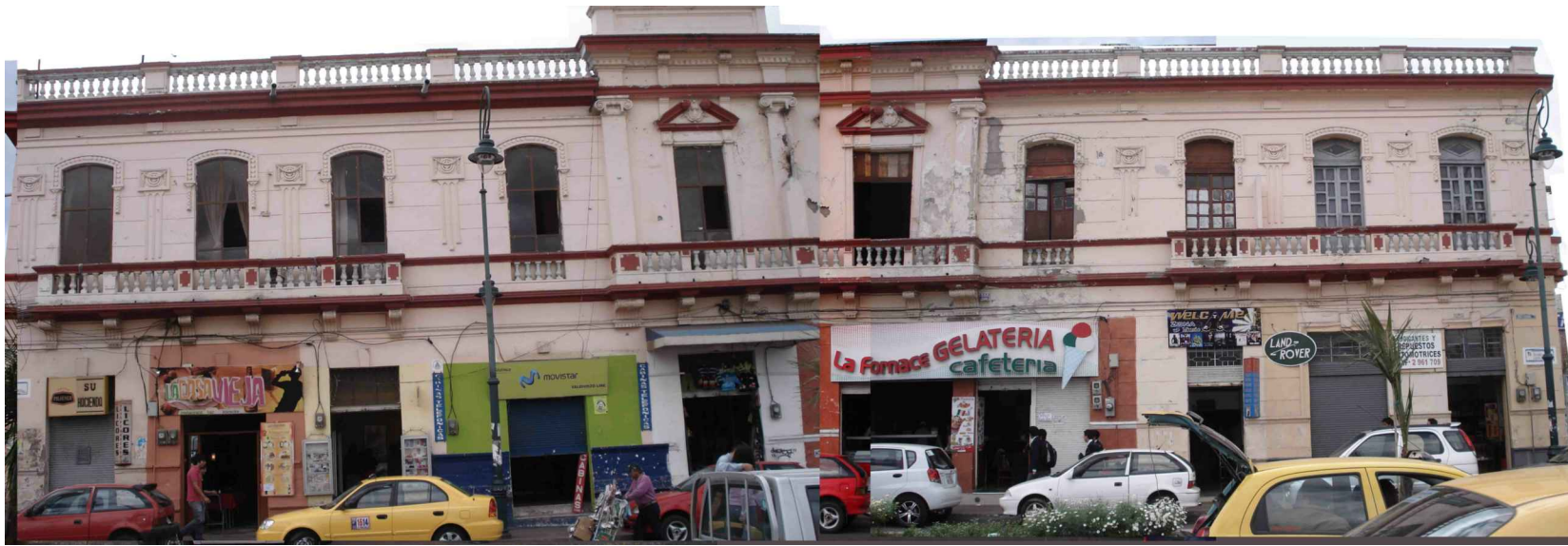
Antes de la intervención
