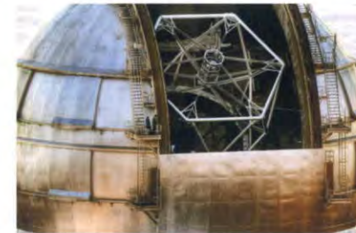
Superestructura Metálica de la Cúpula del GTC
