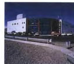
Vista Edificio de Control
