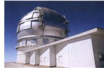
Vista Edificio de Control anexo al telescopio
