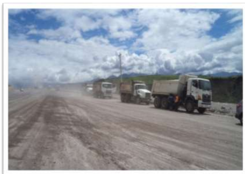
Figura 14. Circulación de maquinaria pesada a lo largo del proyecto
