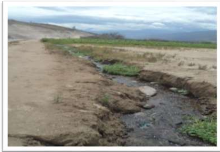
Fuente: Construcción del Paso Lateral de Ibarra
