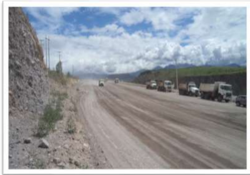
Figura 15. Circulación de maquinaria pesada y de vehículos livianos para transportar al personal de la obra
