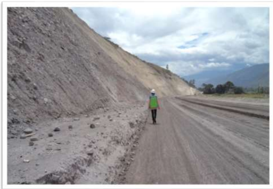
Fuente: Construcción del Paso Lateral de Ibarra
