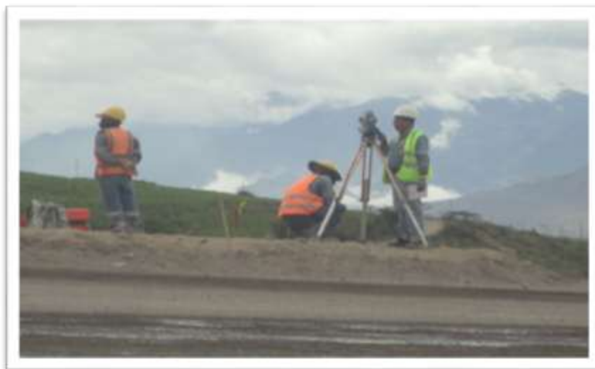
Fuente: Construcción del Paso Lateral de Ibarra
