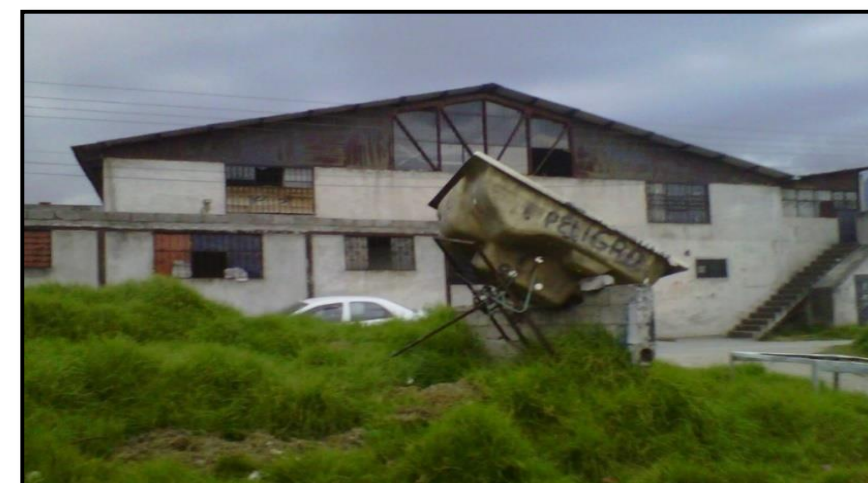
FOTOGRAFÍA 10: VIVIENDAS EN INFRAESTRUCTURA DE FÁBRICA
