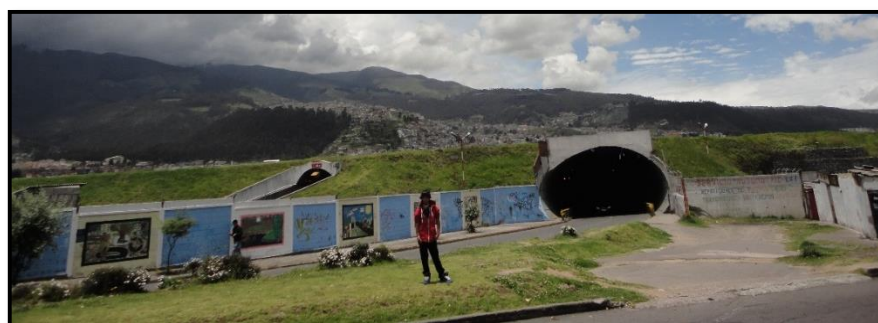
FOTOGRAFÍA 1: APARIENCIA DEL TUNEL VARIOS MESES ANTES DEL DERRUMBE
