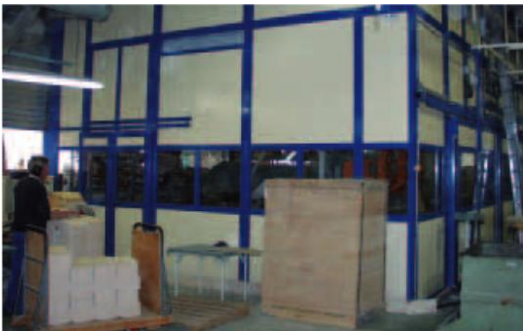
Figura 4. Cierre de equipos para reducción de ruido
