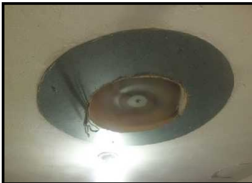
Fotografía 4. Bodega de Agroquímicos y su ventilación interna
