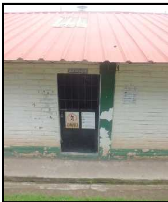
Fotografía 2. Bodega de Ácidos y fachada externa
