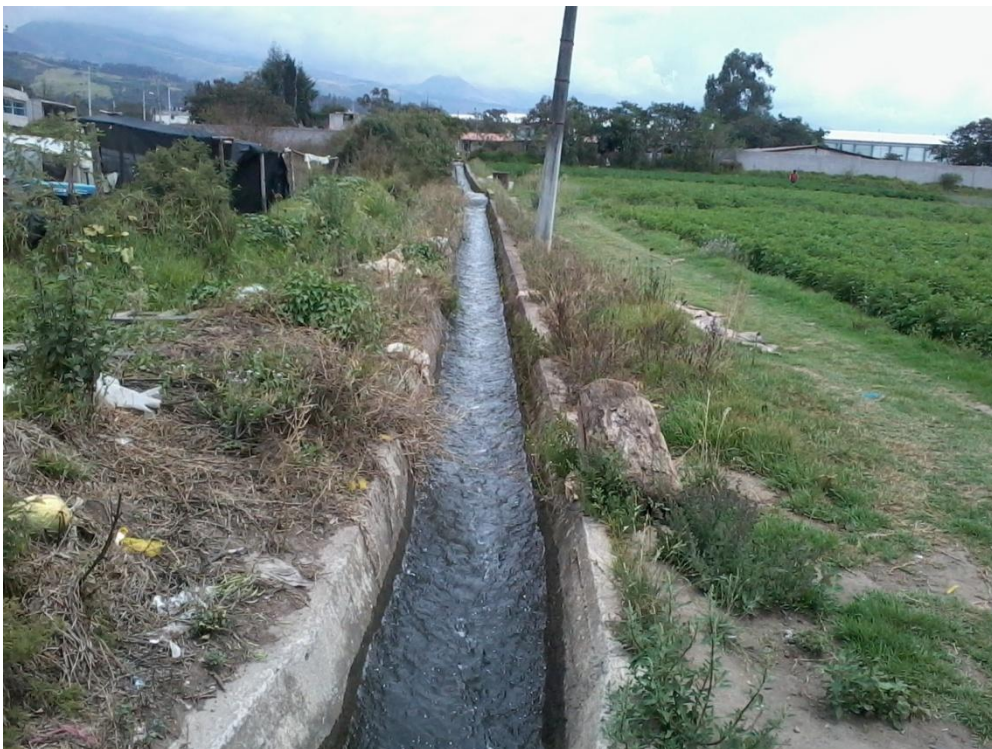
Canal de riego en el sector de Chaupimolino, Pifo – Pichincha.
