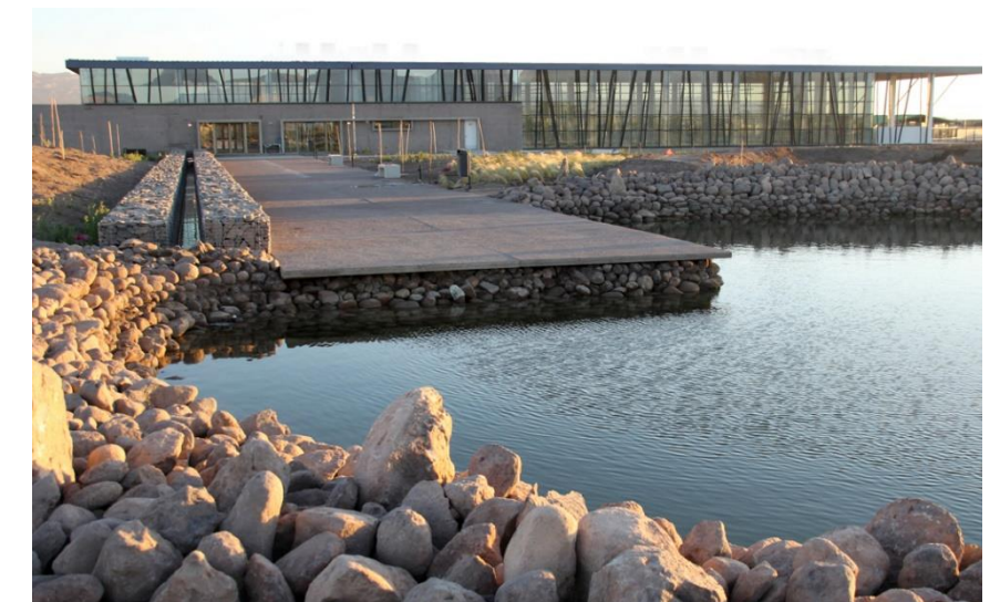
Imagen 23. Centro Deportivo Codelco – Estructura
