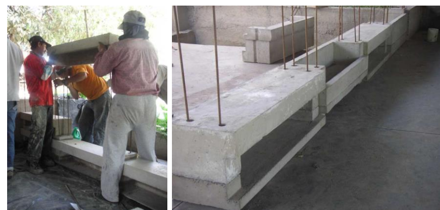
FOTOGRAFIA 34 Ensamble de prefabricados Casa Pentimento Fuente: arqsaez.com
