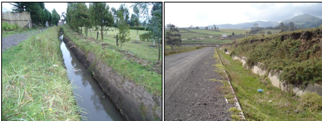
Foto 8 y 9. Acequia Tabacundo y Canal de riego Cayambe-Pedro Moncayo en construcción
